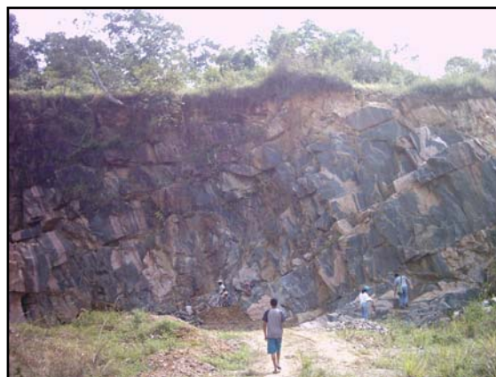
Figura 8.6: Pedreira ativa na saída de Ibirataia.
