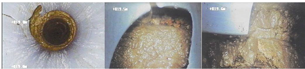
Figura 2 - Tubo de revestimento que encontra-se solto no poço, e sua parte inferior quebrado.
