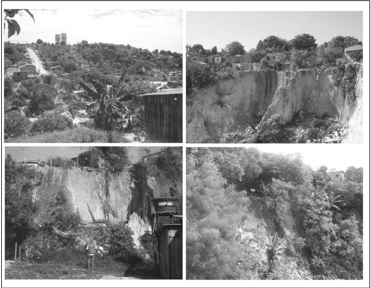
Figura 3. Áreas de risco na zona leste de Manaus: Foto 1. Arruamento do bairro Gilberto Mestrinho paralelo ao fluxo de águas pluviais; Foto 2. Presença de grandes anfiteatros formados por voçorocas; Foto 3. Situação das moradias muito próximas às áreas escarpadas tanto no sopé quanto no alto do talude; Foto 4. Utilização de feijão erosivo como lixão a céu aberto, observar bananeiras na encosta que aumentam a chance de deslizamentos do talude, pelo acúmulo e peso da água, que essa planta acumula em sua base.
