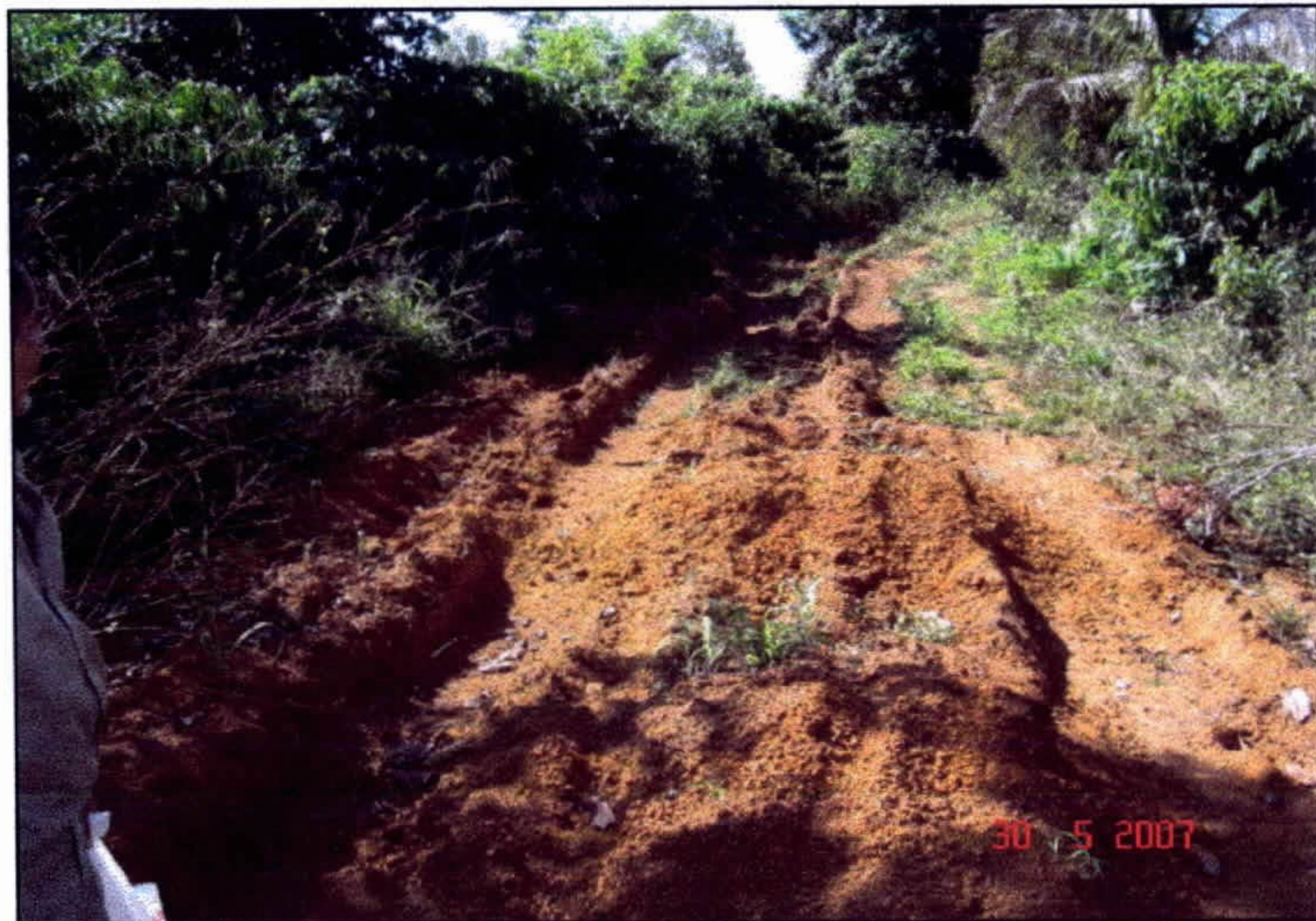
Foto 9. Valas secas devido a infiltração e/ou evaporação.
