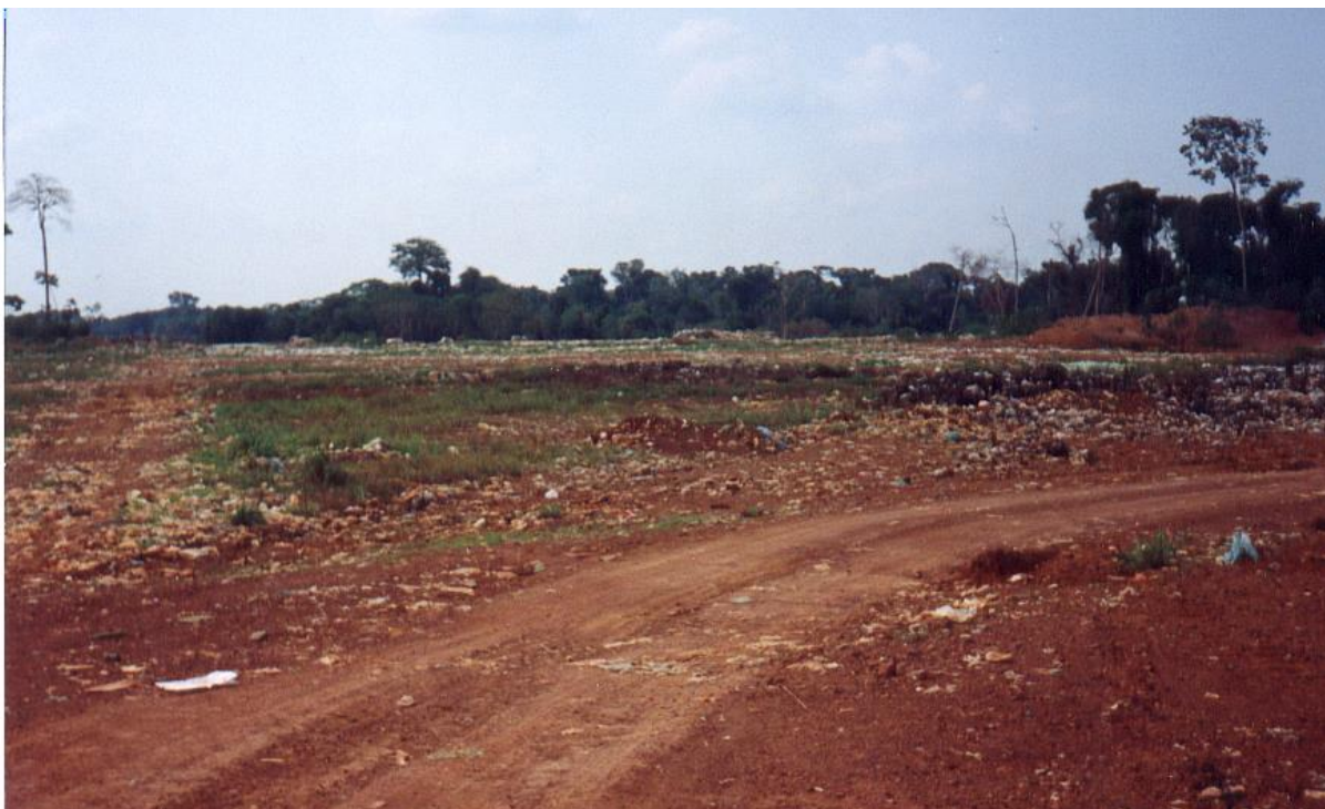
Foto 1: Vista geral do Depósito de Lixo de Porto Velho. Em primeiro plano aparece uma área que antigamente recebia cobertura de solo. Ao fundo, verifica-se a disposição atual, sem nenhuma cobertura. Não há também sistema de drenagem de gases.
