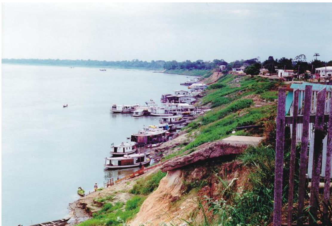
Figura 4 – Foto mostrando o porto fluvial da cidade de Humaitá, com grandes desbarrancamentos seccionando vários trechos da avenida marginal e comprometendo edificações privadas e públicas, dentre elas o cemitério da cidade. Alguns monumentos históricos também estão ameaçados, como a Igreja Matriz.
