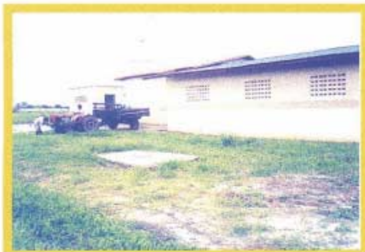
Foto 12 - Placanteira utilizada para disposição do rejeito proveniente da sala de cirurgia.
