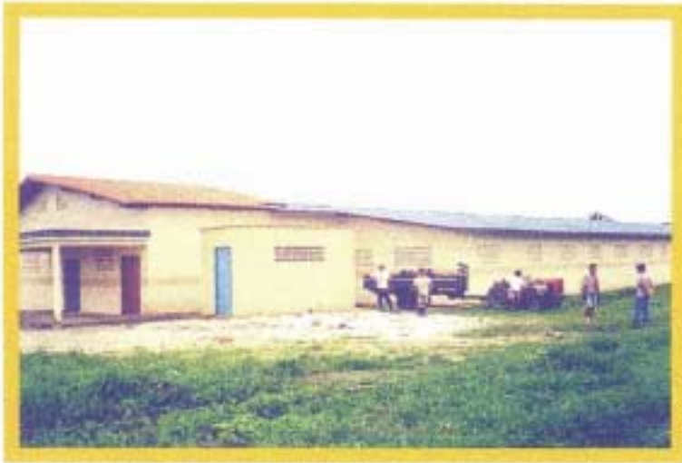
Foto 10 - Acondicionamento e armazenamento do lixo de alto risco.
