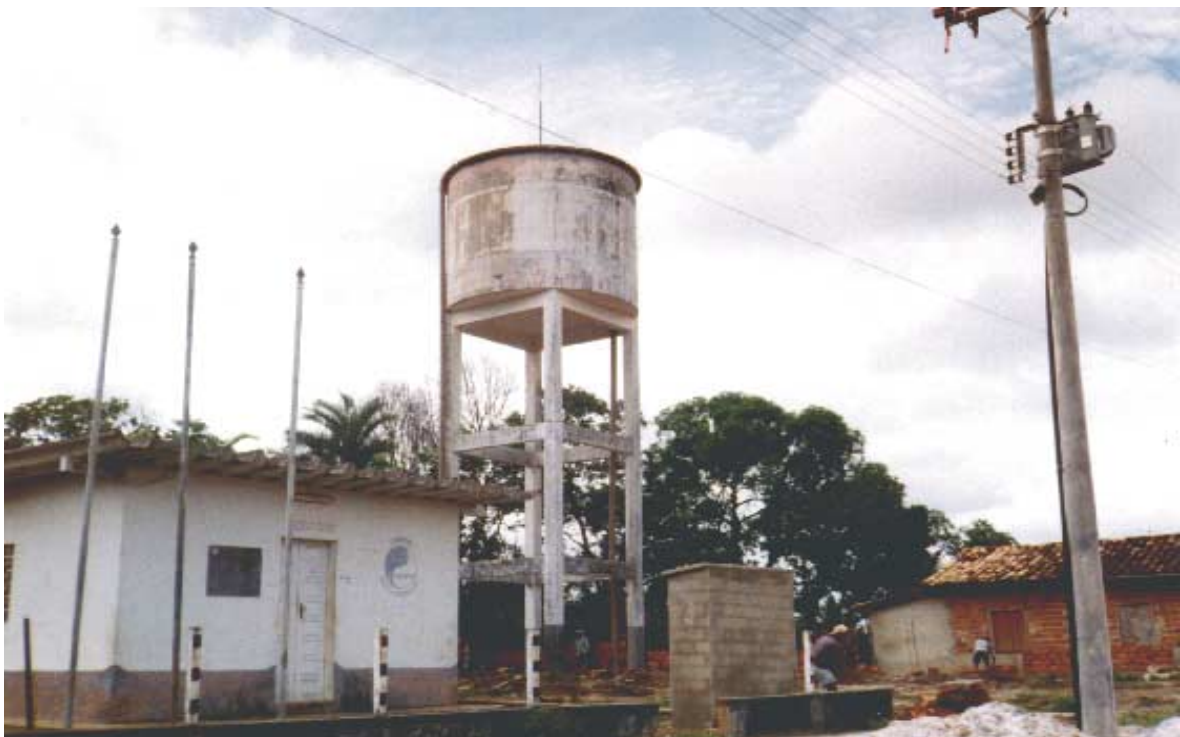
Foto 02 - Elevatória e poço da CPSANPA para para regularizar a situação do abastecimento de água da cidade de Urumajó.
