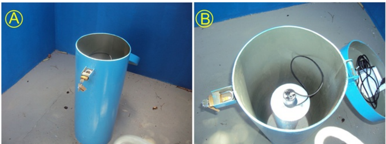
Figura 11: Poço de monitoramento no aquífero Cabeças, município de Brasileira-Piauí: (A) Tubo de proteção externa, com sistema de travamento; (B) Disposição do equipamento de monitoramento inserido no revestimento interno do poço.
