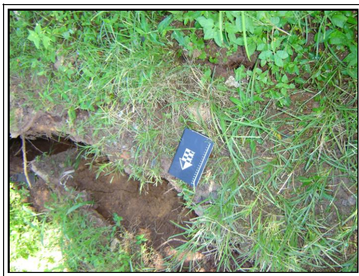
Figura 3 - Trincas no solo, indicando avanço ativo da erosão.
