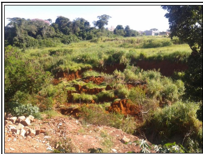
Figura 5 - Abatimento do solo indicando o avanço da erosão.
