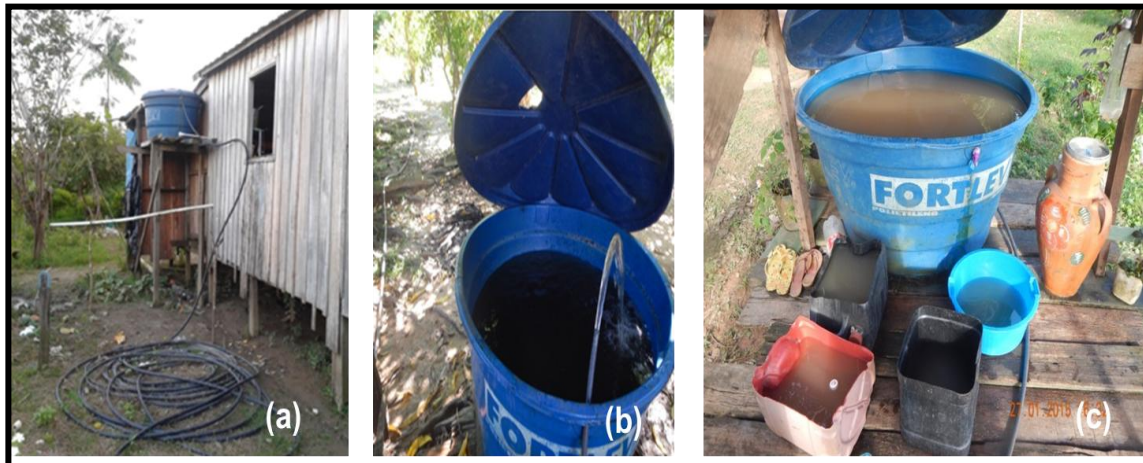
Figura 14. Registro da captação e do armazenamento (a, b, c). Foto: Próprio autor
