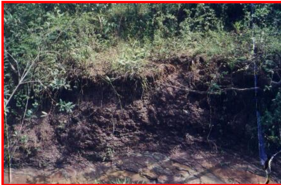
Foto 3. Pequena drenagem, seccionando o Lote 4.
