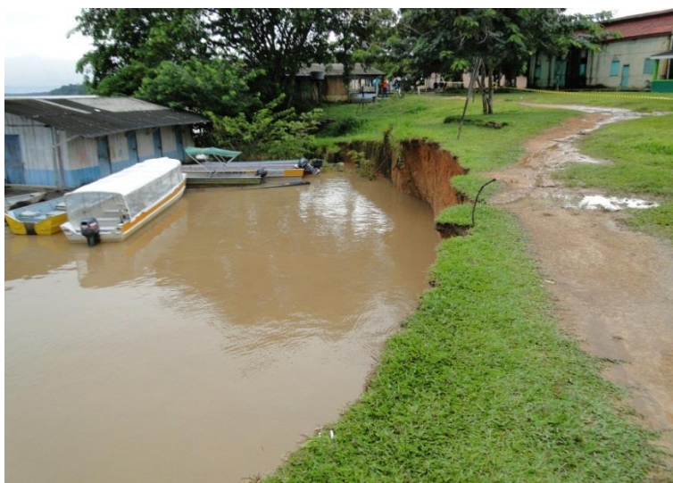
Figura 10. Avanço da frente erosiva fluvial em Calama.
