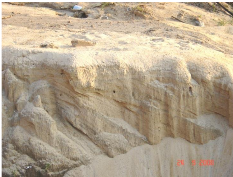
Figura 12. Sedimentos arenosos estratificados em desagregação.
