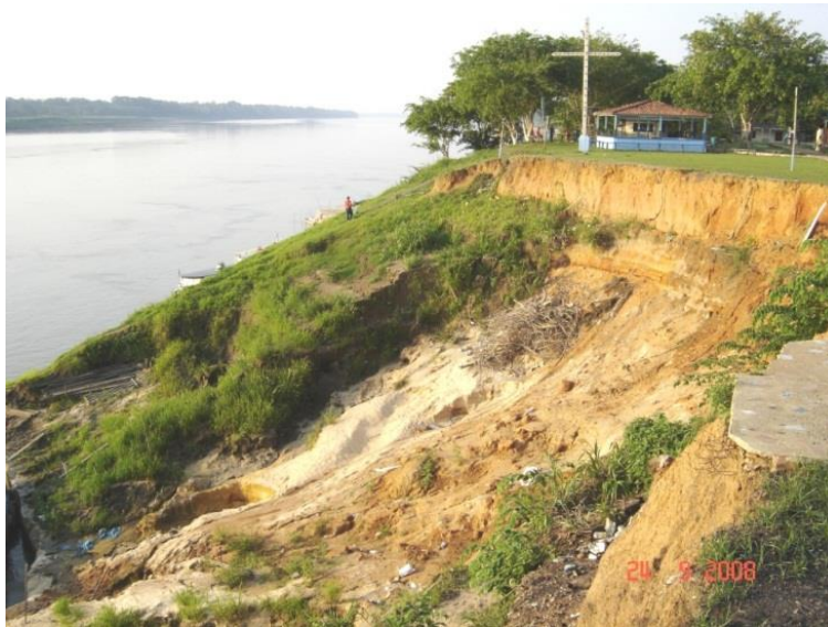
Figura 11. Vista lateral do talude marginal próximo a Igreja Católica.
