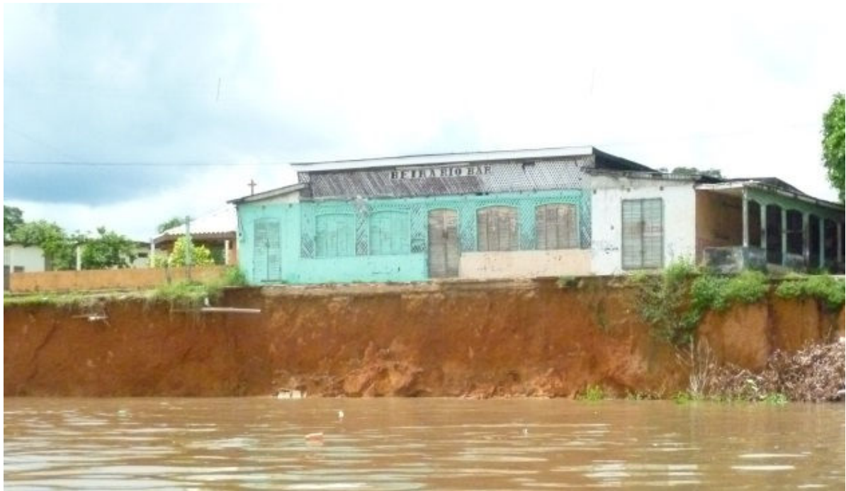
Vista da seção transversal de medição 04 - Margem direita.
