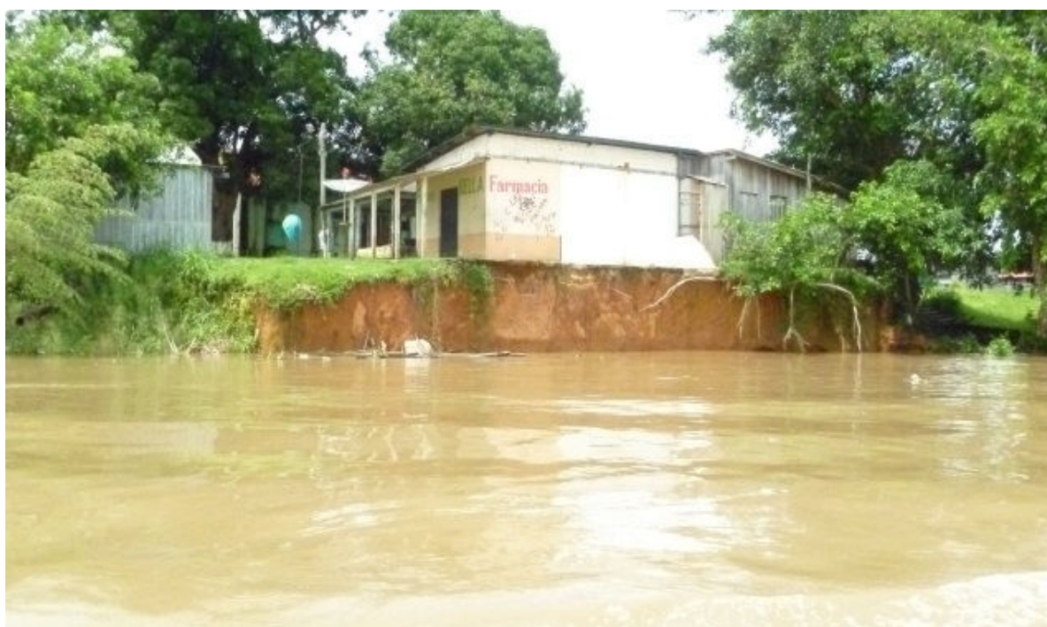
Vista da seção transversal de medição 03 - Margem direita.
