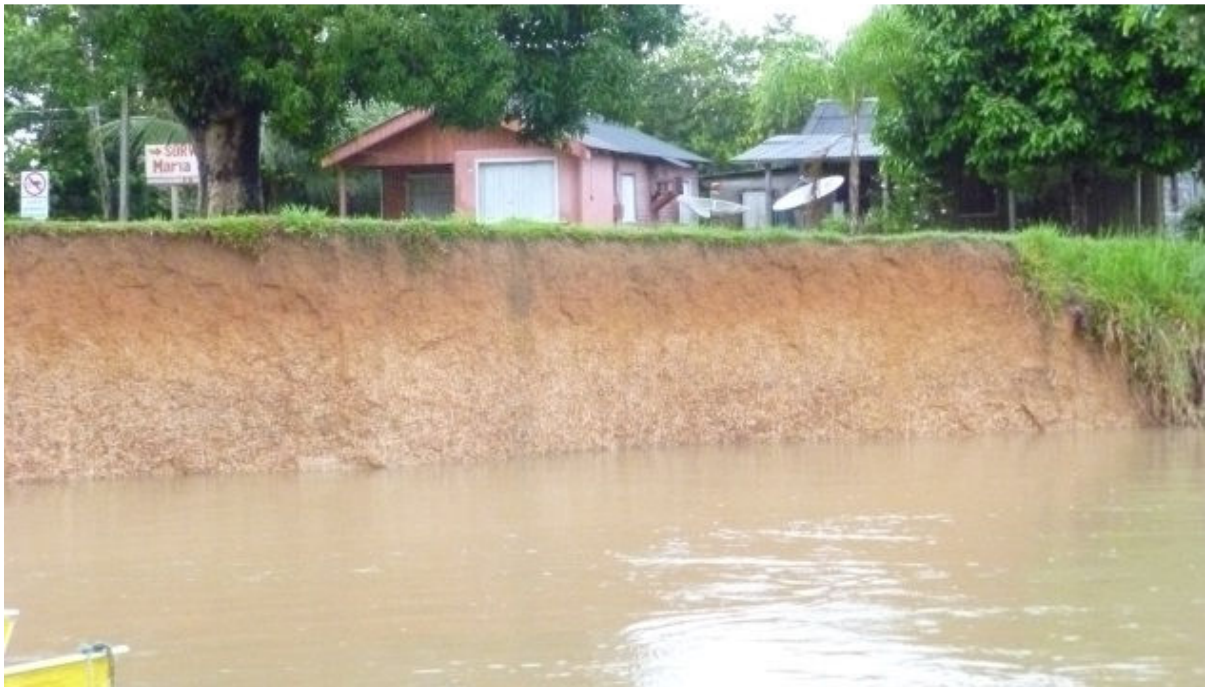
Vista da seção transversal de medição 06 - Margem direita.
