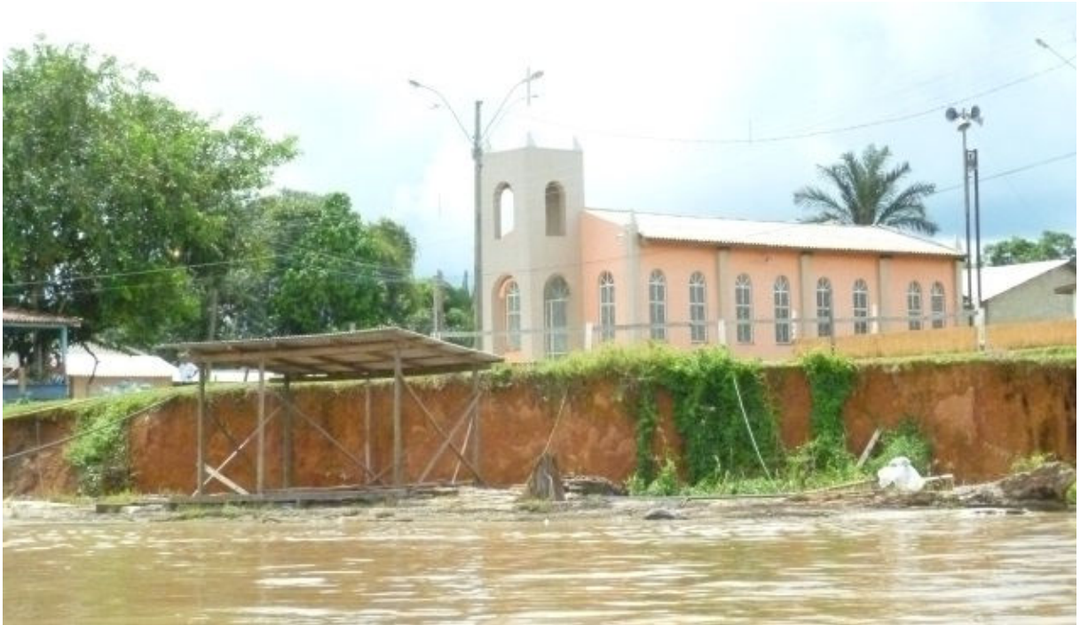
Vista da seção transversal de medição 05 - Margem direita.
