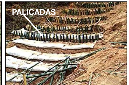
Paliçadas que podem ser construídas com materiais de baixo custo como bambu, pneus usados e sacos de rafia, quebram a força da enxurrada, diminuindo a erosão e retendo sedimentos dentro da voçoroca.
