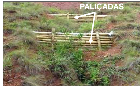
Paliçadas que podem ser construídas com materiais de baixo custo como bambu, pneus usados e sacos de rafia, quebram a força da enxurrada, diminuindo a erosão e retendo sedimentos dentro da voçoroca.
