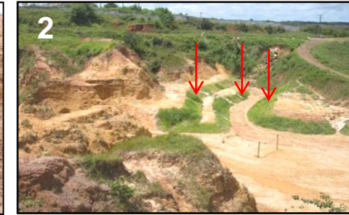
Foto 1: aplicação de tela biodegradável feita com fibra de buriti para fixar os sedimentos e as sementes na parede da voçoroca e agilizar a revegetação, visando minimizar o processo erosivo. Foto 2: resultado da revegetação no interior da voçoroca.
