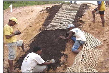
Foto 1: aplicação de tela biodegradável feita com fibra de buriti para fixar os sedimentos e as sementes na parede da voçoroca e agilizar a revegetação, visando minimizar o processo erosivo. Foto 2: resultado da revegetação no interior da voçoroca.
