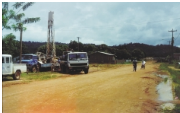
Foto 4 - Poço tubular (Pt01) sendo perfurado na Av. 1º de maio.
