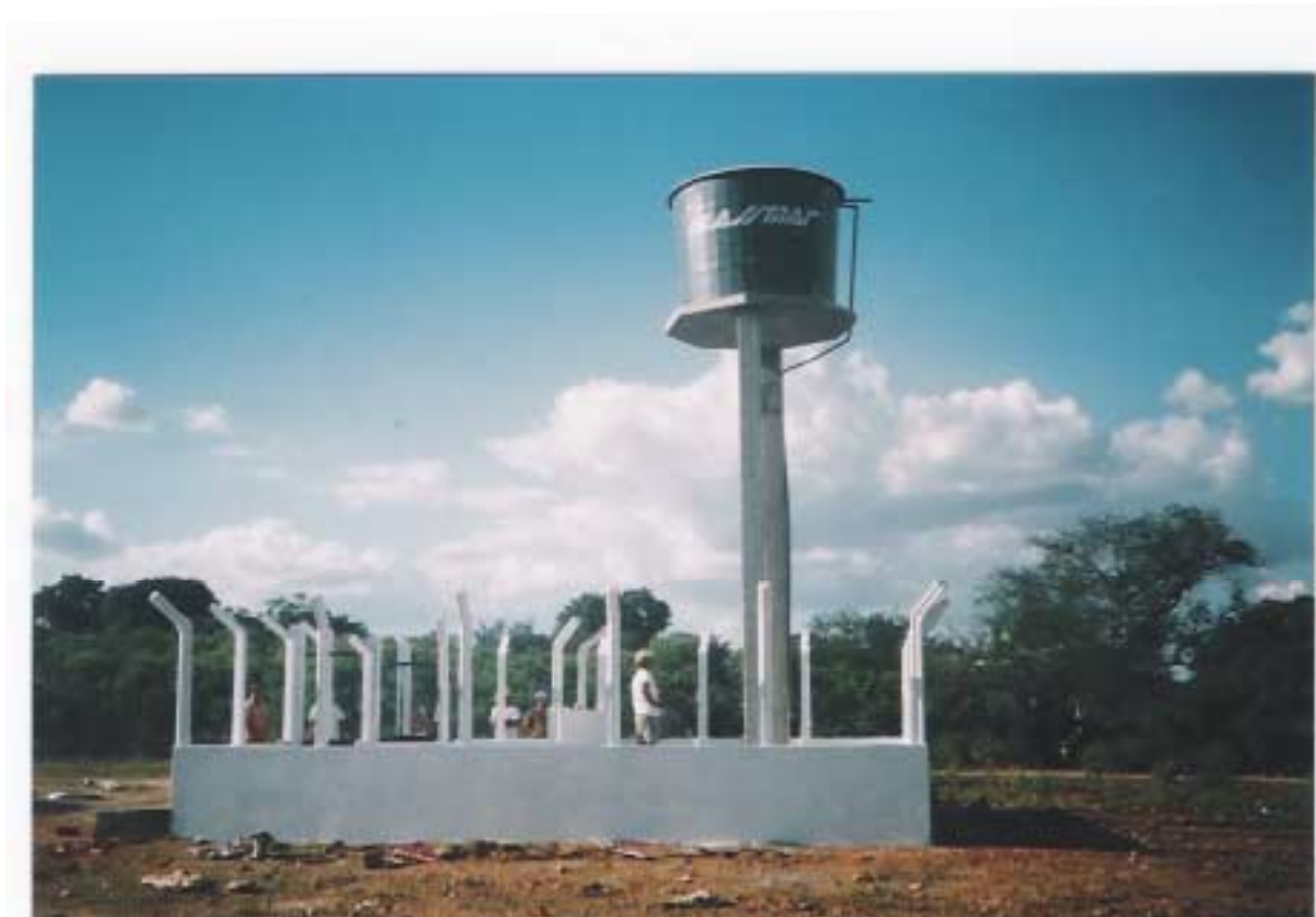
Foto 8.1 - Aspecto do SSA Sítio Bom Jesus concluído
