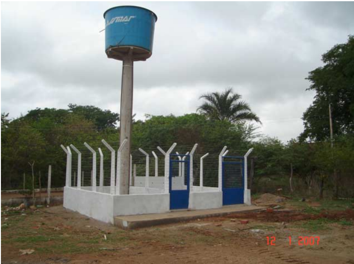
Foto 8.1 - Aspecto do SSA Sítio Varjota concluído
