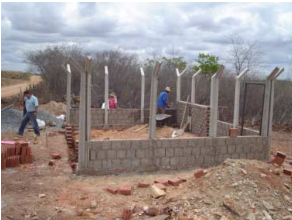
Foto 7.1 - Fase construtiva inicial do SSA Sítio Barreiro Branco
