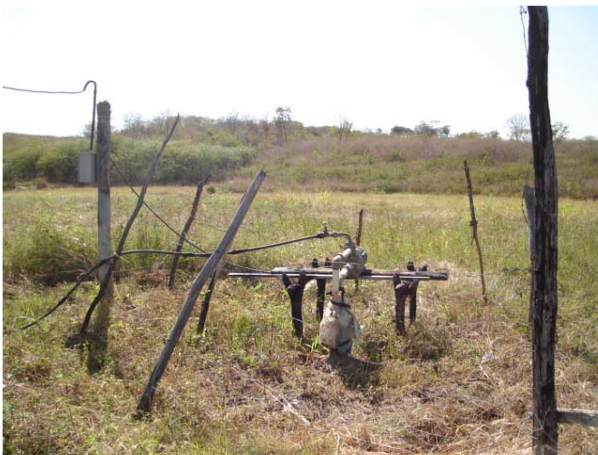
Foto 2.1 - Instalações pretéritas do poço
