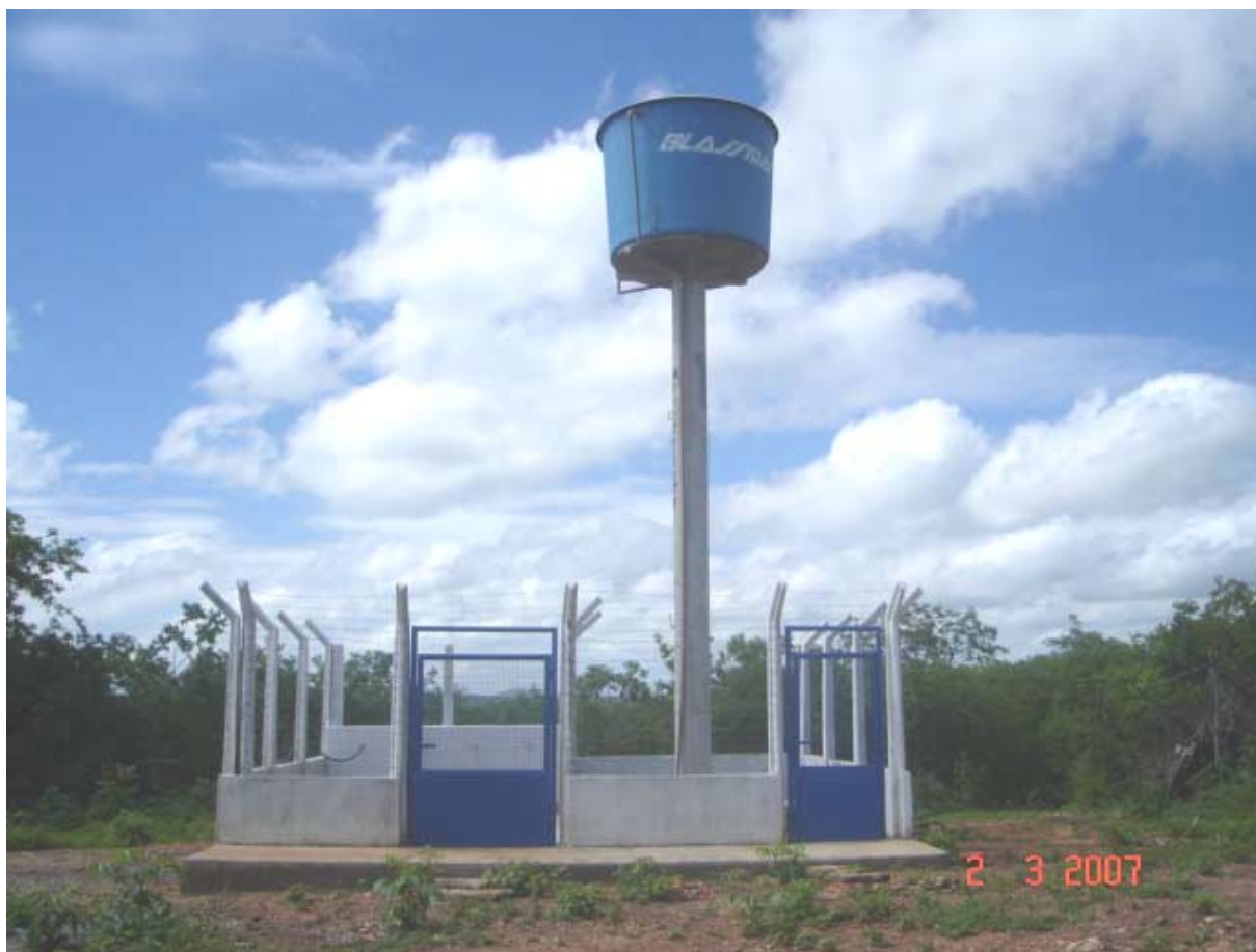
Foto 8.1 - Vista geral do SSA Sítio Barreiro Branco concluído
