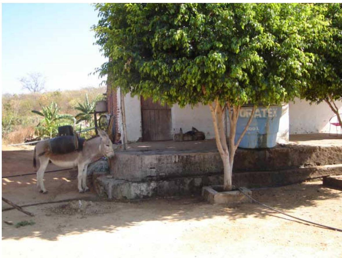
Foto 2.2 - Reservatório de 1000 l do sistema pretérito
