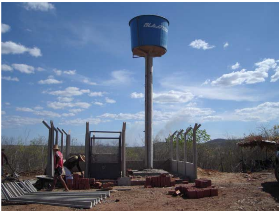
Foto 7.2 - Estrutura do reservatório elevado
