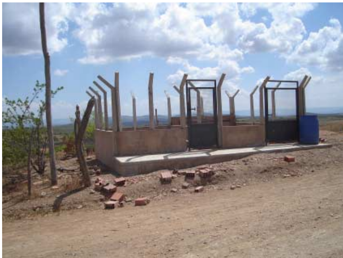
Foto 7.1 - Cercado de proteção do poço
