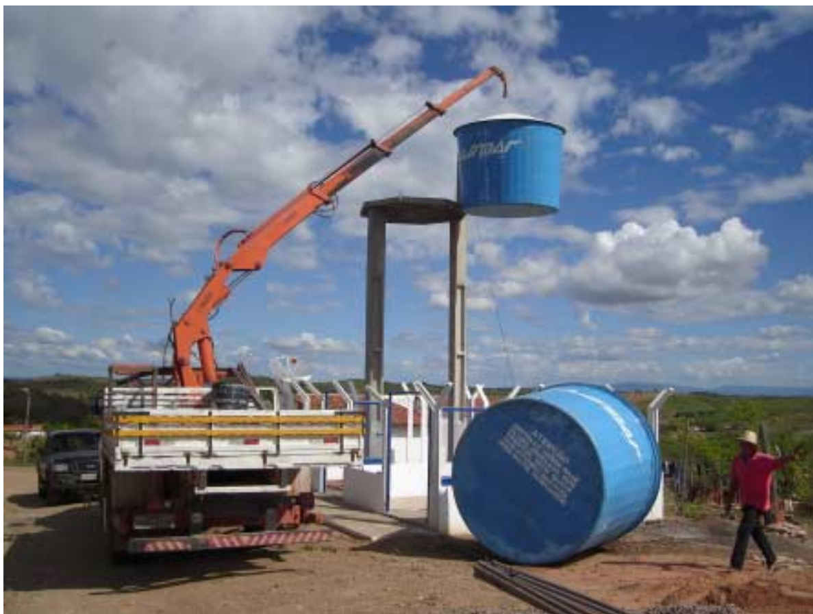
Foto 7.2 - Estrutura pré-moldada da caixa elevada
