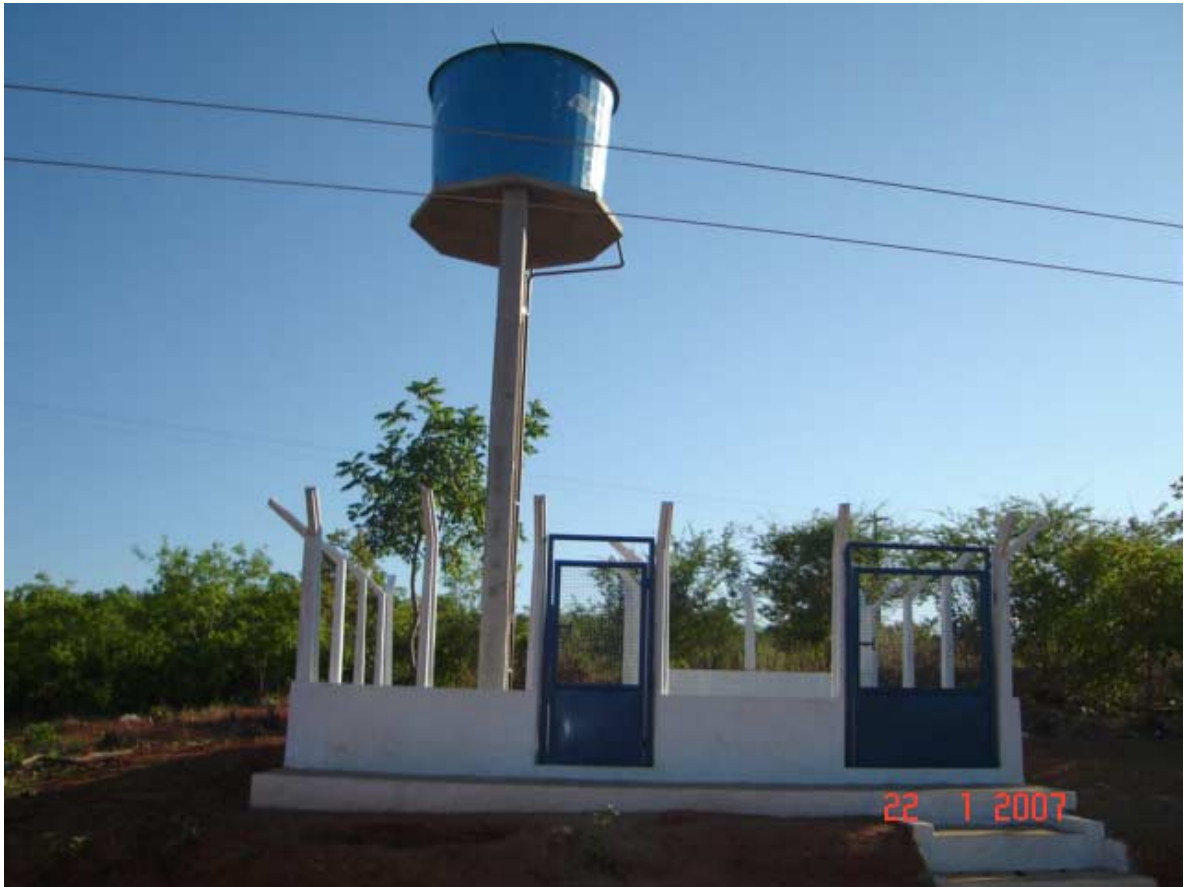
Foto 7.2 - Aspectos do SSA Sítio Monte Serrat I concluído
