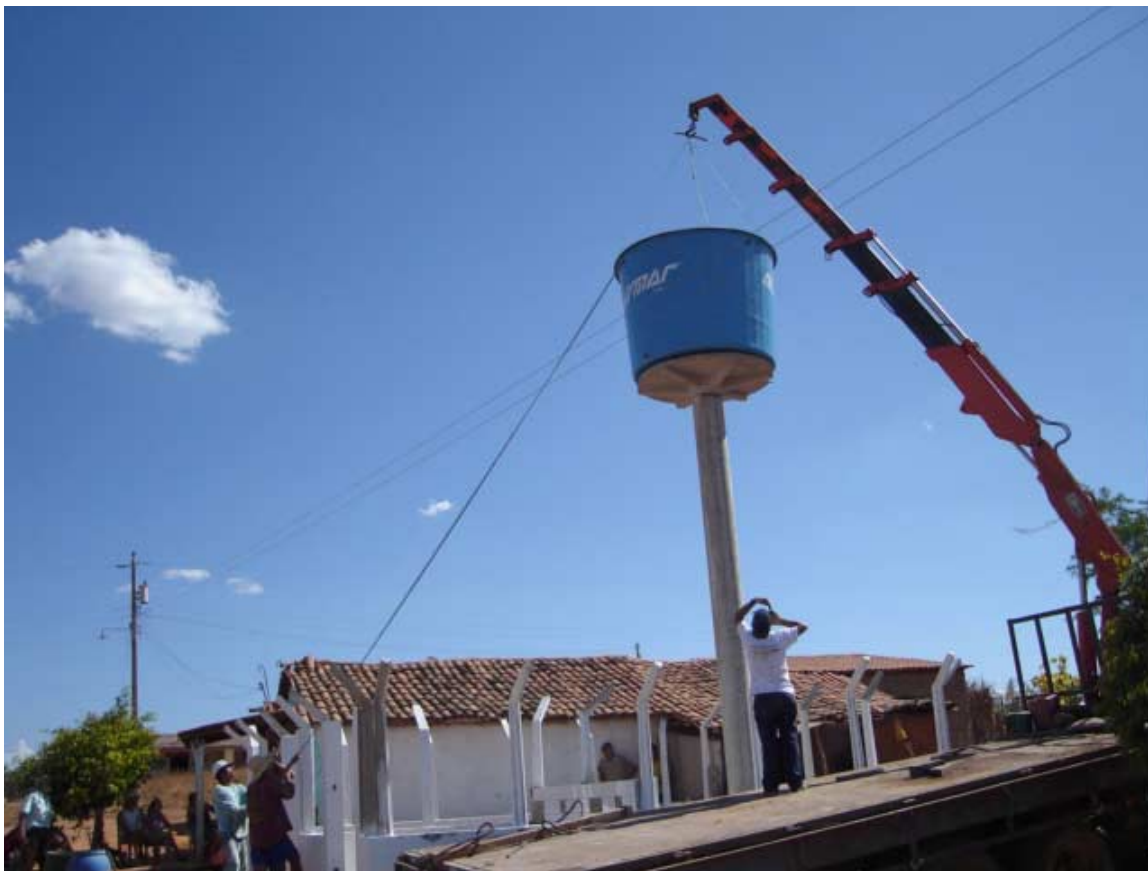
Foto 7.1 - Munck utilizado na montagem do sistema caixa
