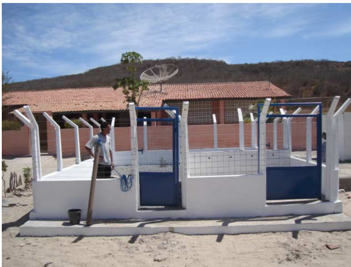
Foto 7.2 - Aspectos da construção do SSA Sítio Taboá
