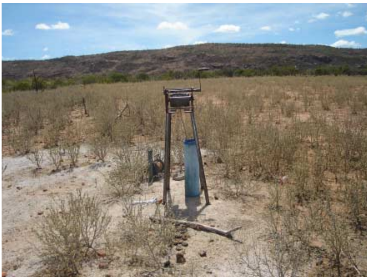
Foto 5.1 - Diagnóstico técnico do poço
