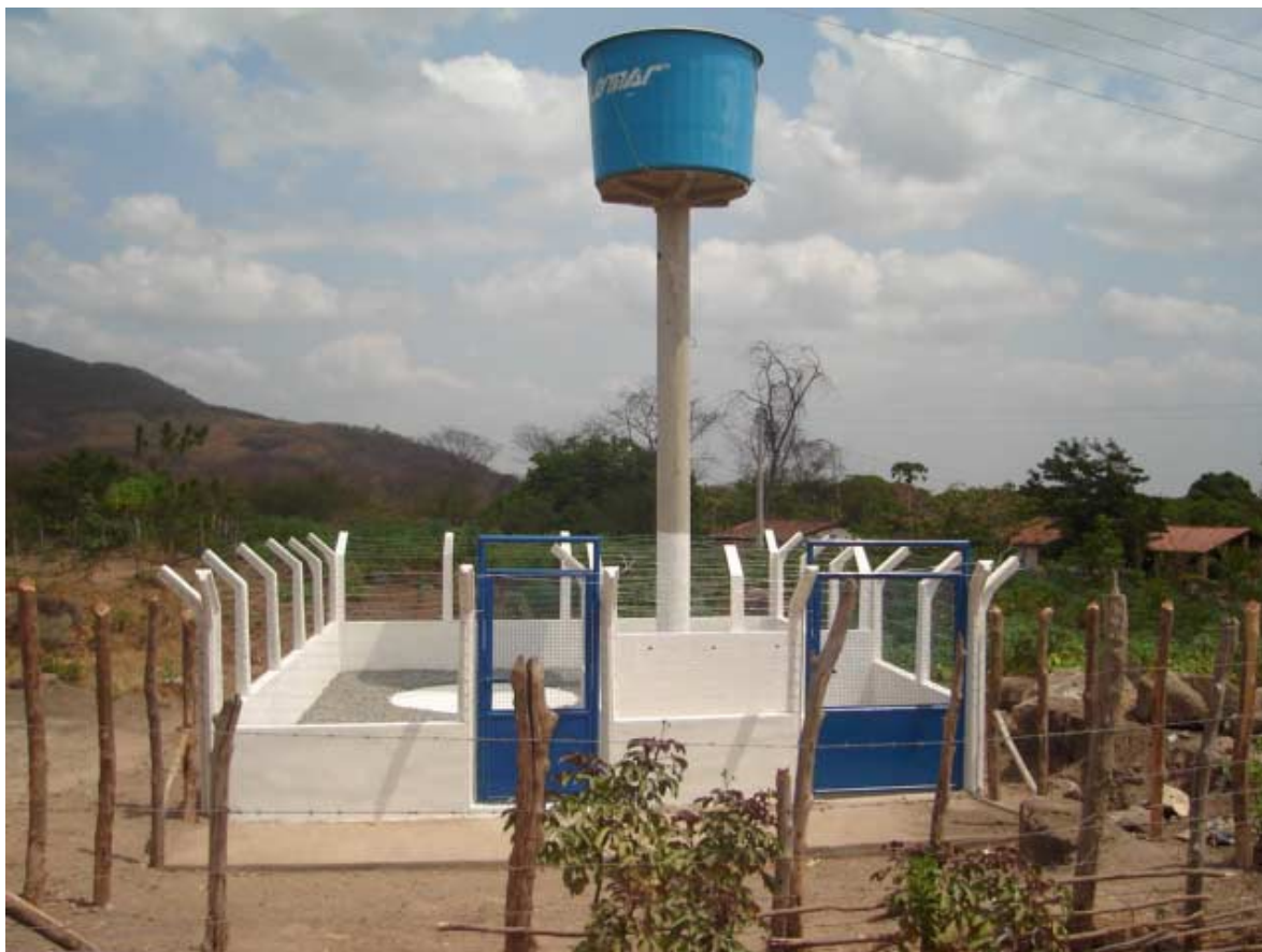
Foto 8.1 - Aspecto do SSA Povoado Barro Vermelho II concluído
