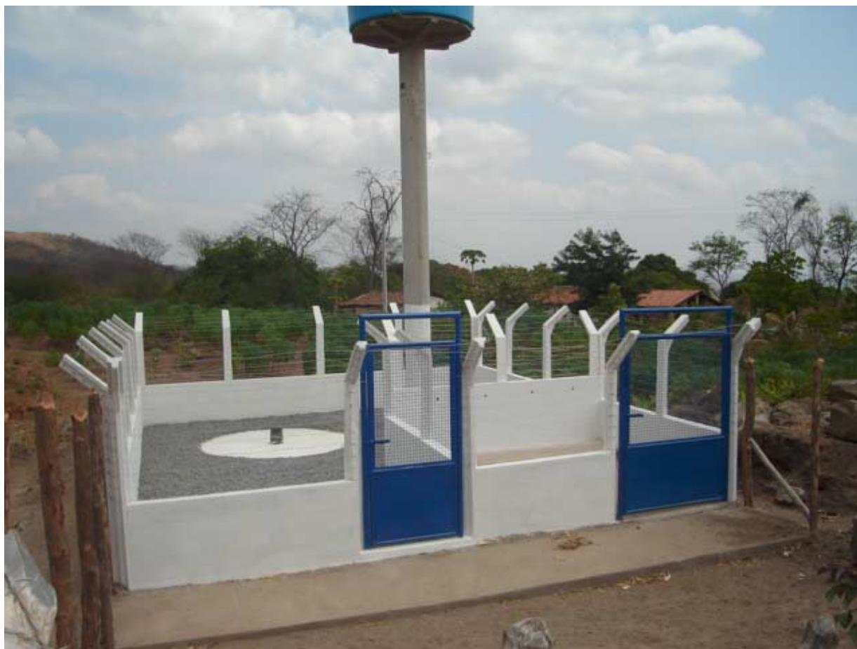
Foto 7.1 - Cercado de proteção do poço
