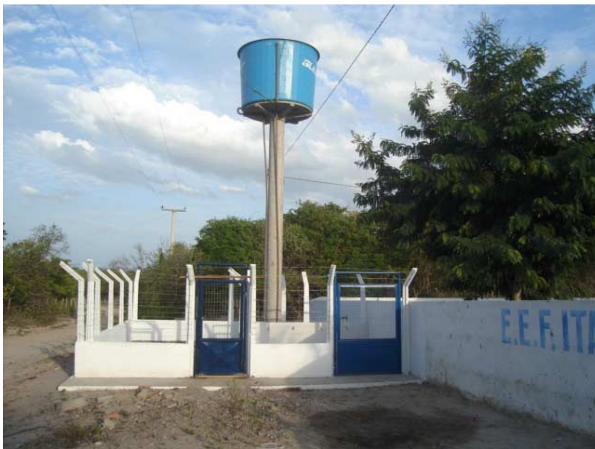
Foto 8.1 - Aspecto do SSA Sítio Boqueirão do Itaguruçu concluído
