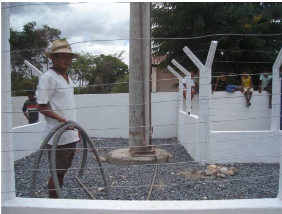
Foto 7.1 - Fase construtiva final do SSA Sítio Boqueirão do Itaguruçu
