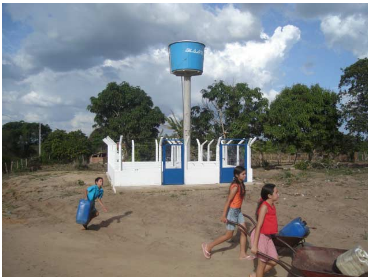
Foto 8.1 - Aspecto do SSA Sítio Pindaré concluído
