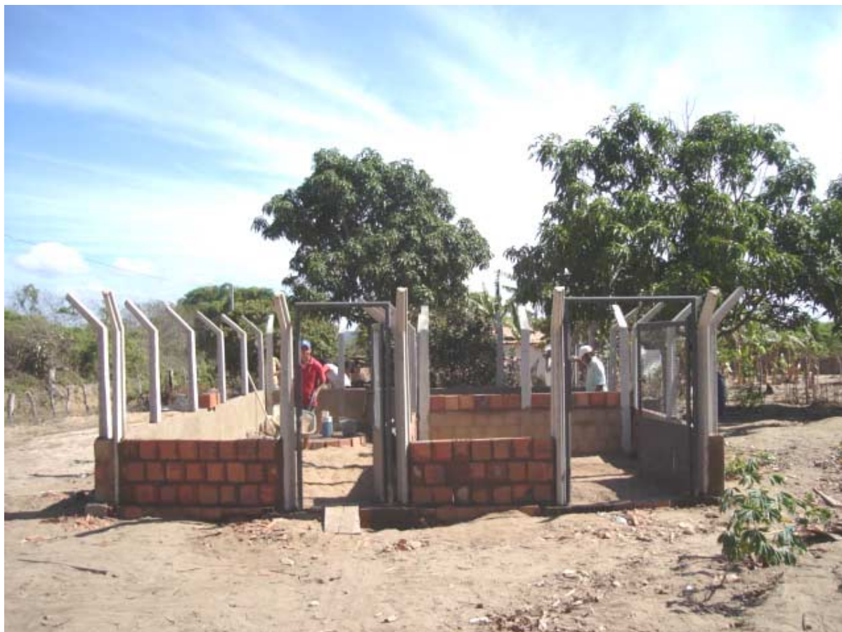
Foto 7.1 - Fase construtiva inicial do SSA Sítio Pindaré
