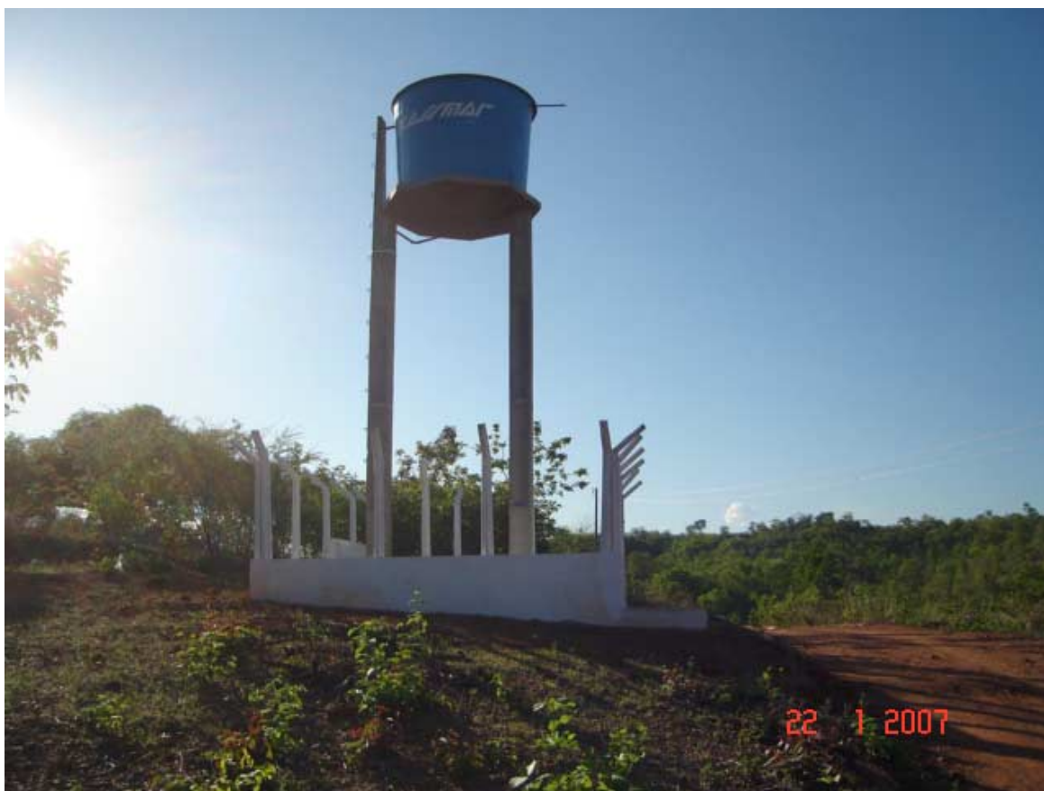
Foto 8.1 - Aspecto do SSA Sítio Monte Serrat II concluído
