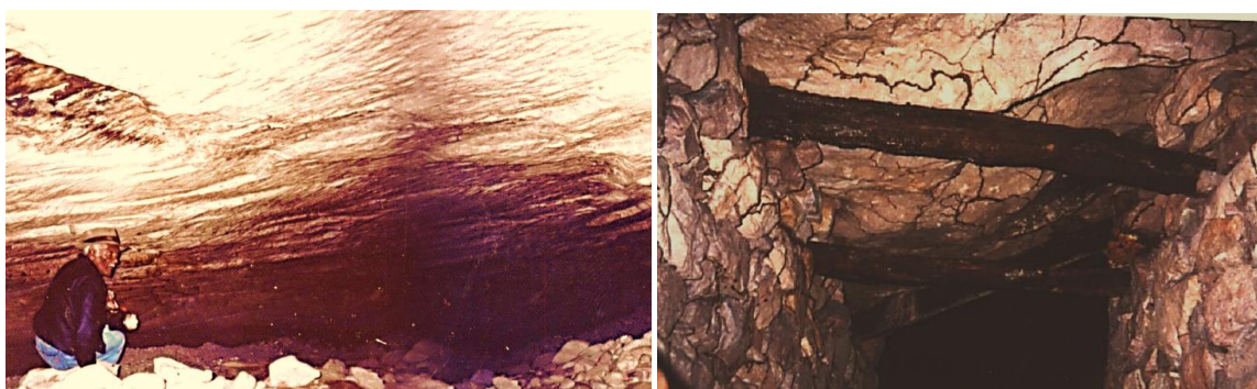
Figura 9 – À esquerda, gruna entre Mucugê e Igatu. À direita, detalhe de suporte de teto e paredes na Gruna do Brejo, Igatu, Andaraí, construída pelo Garimpo.
