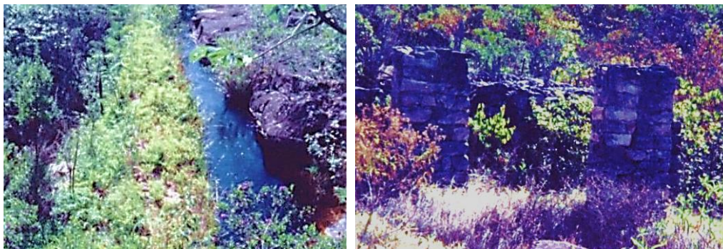
Figura 4 – Estruturas garimpeiras de adução de água de extensões quilométricas. À esquerda, Rego das Laranjeiras, e a direita, socalca do Bairro Luis dos Santos, mostrando a parte das colunas de suporte e a calha de zinco. Dimensões das colunas: 2m de altura por 3m de largura. Igatu, Andaraí.
