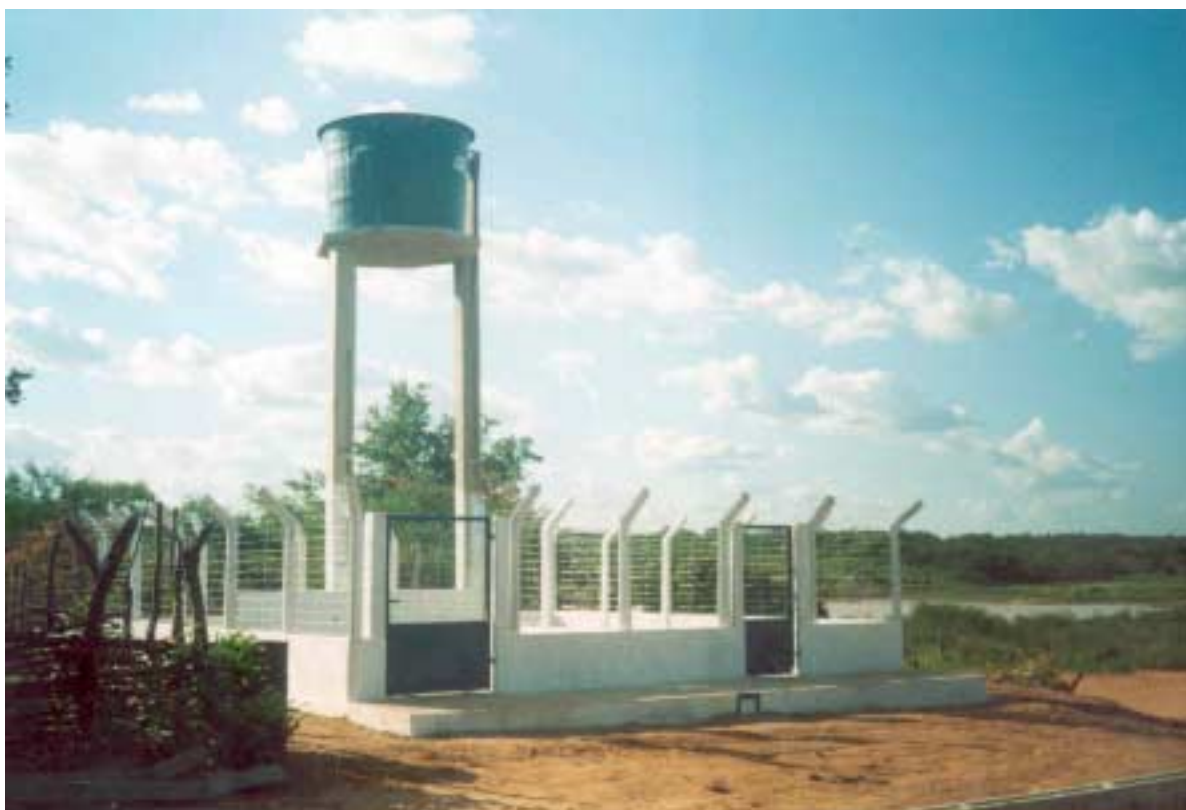
Foto 8.1 – Aspectos do SSA Vidéu Velho concluído
