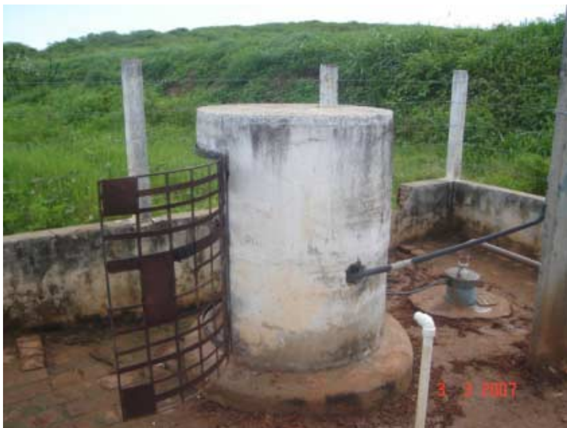
Foto 2.1 - Situação pretérita do poço
