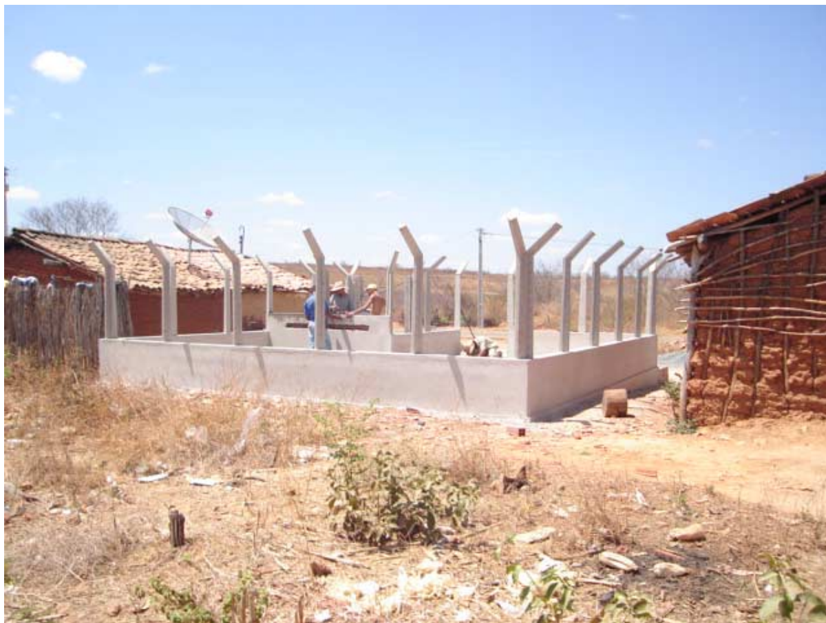
Foto 7.1 - Fase construtiva, mostrando arranjo físico das estacas pré-moldadas, SSA Sítio Umarizeiras II.
