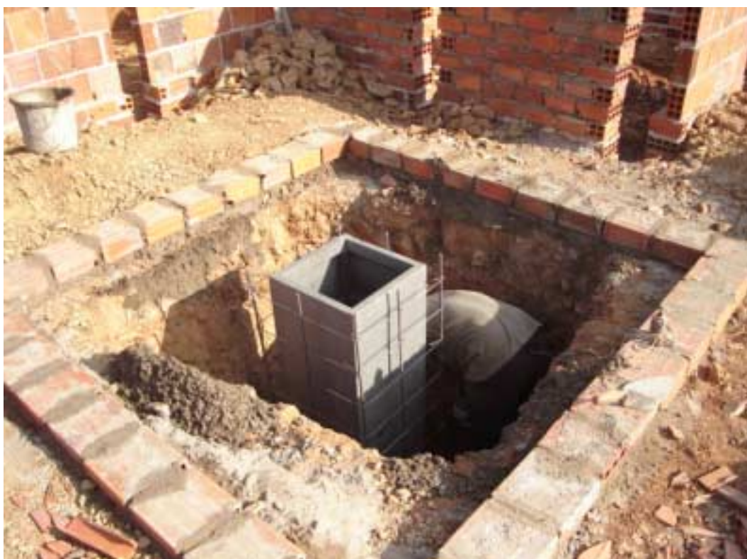
Foto 7.2 - Fase de concretagem, em execução, da fundação - Sítio Umarizeiras II
