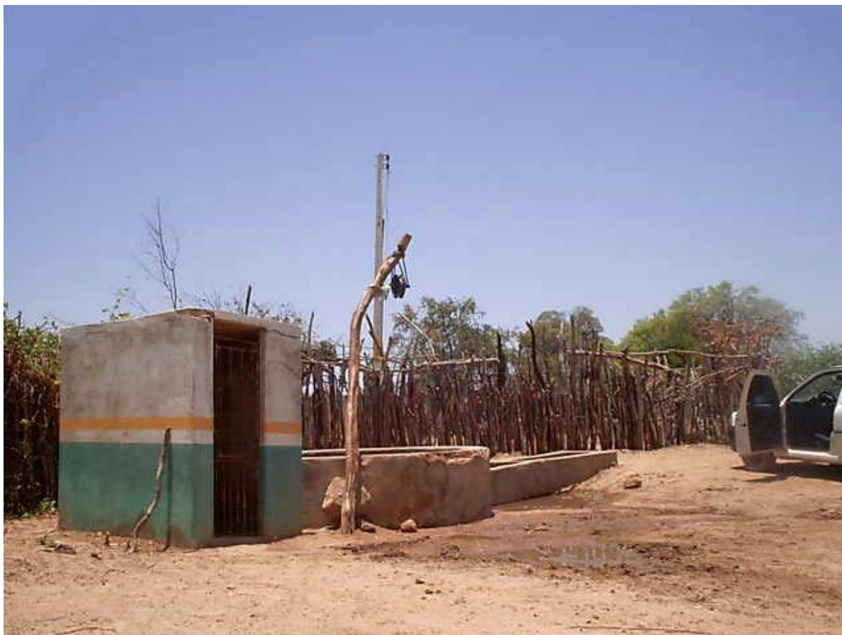
Foto 5.1 - Condições pretéritas, sanitárias, físicas e de operação do poço escavado
