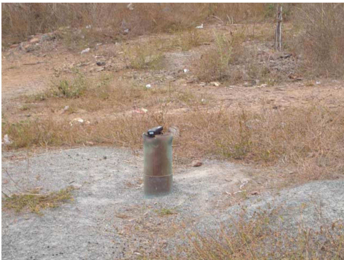
Foto 5.2 - Diagnóstico técnico do poço do Sítio Espriado
