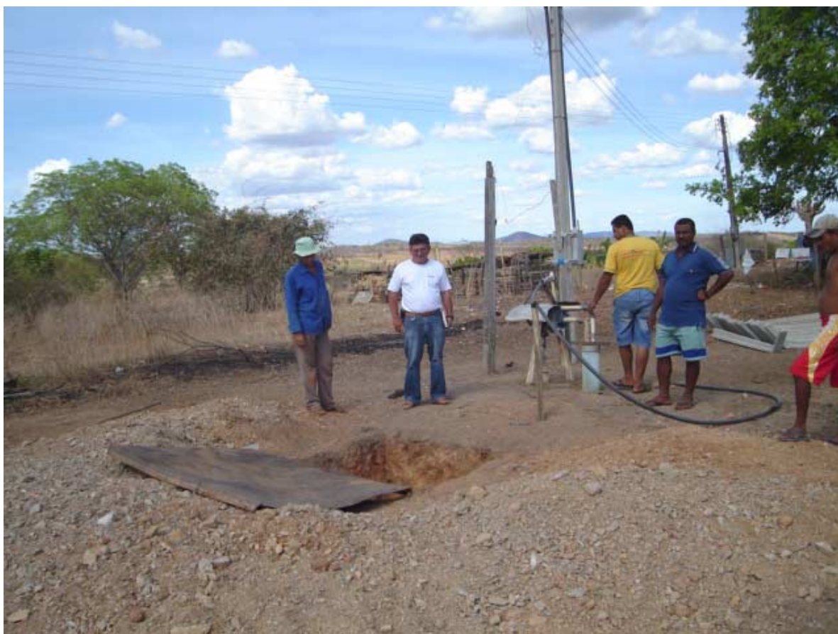
Foto 7.1 - Início das obras do SSA Sítio Lagoa do Machado
