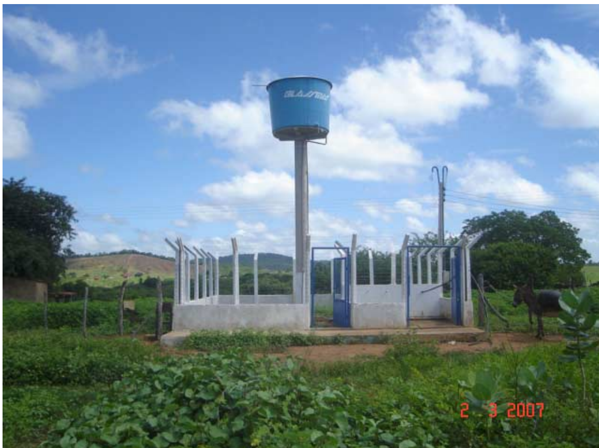
Foto 8.1 - Aspecto do SSA Sítio Lagoa do Machado concluído
