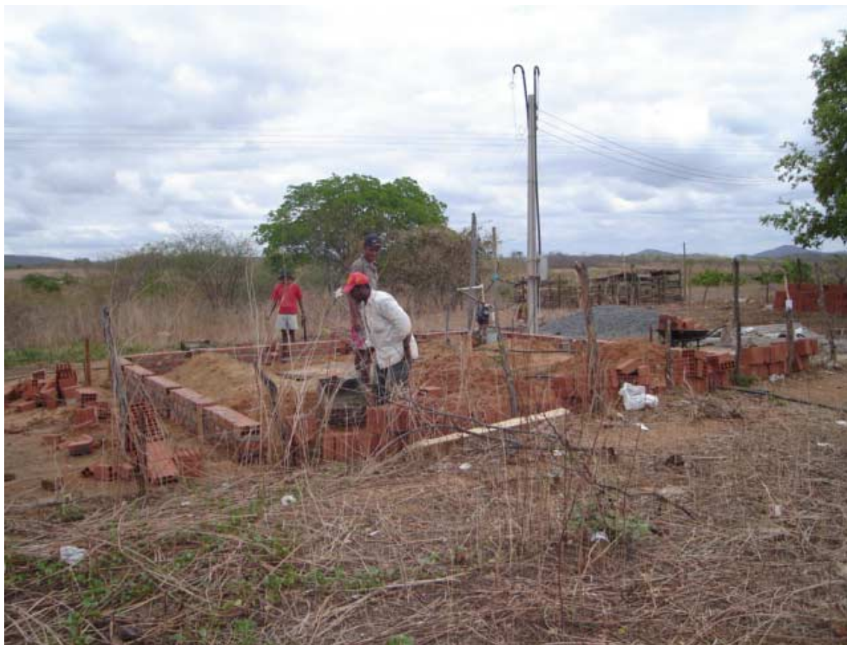
Foto 7.2 - Fase construtiva inicial do SSA Sítio Lagoa do Machado
