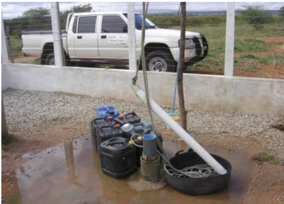
Foto 8.1 - Uso do sarilho no poço HS481, já revestido com 4"
