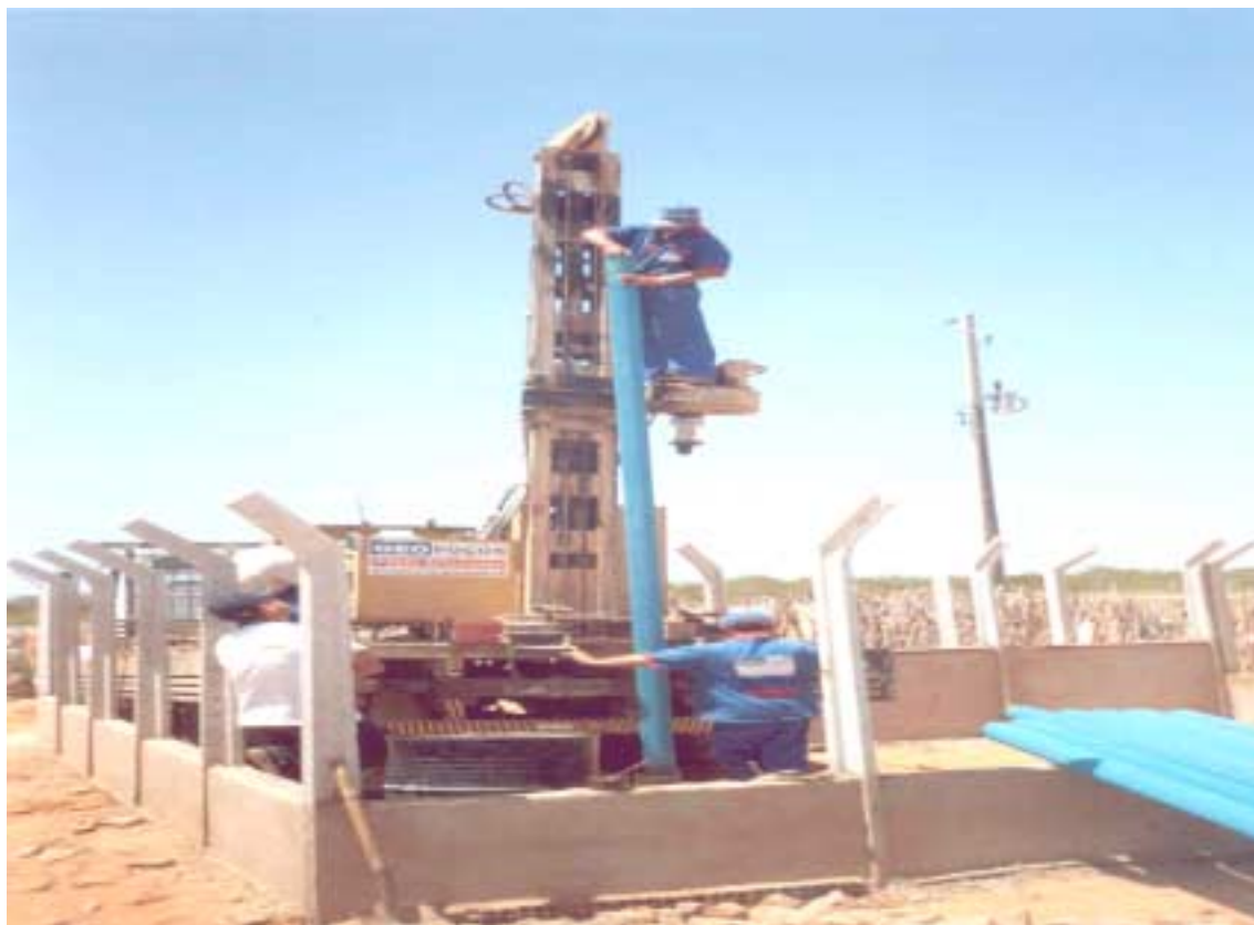
Foto 5.1 - Operação de revestimento do poço HS481
