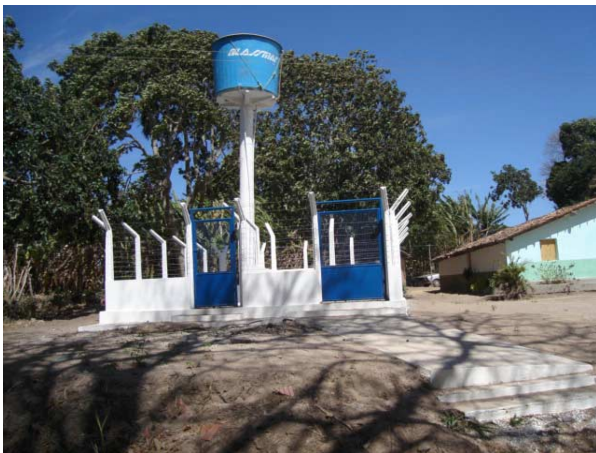
Foto 7.2 – Visão geral do SSA Sítio Salgado II concluído
