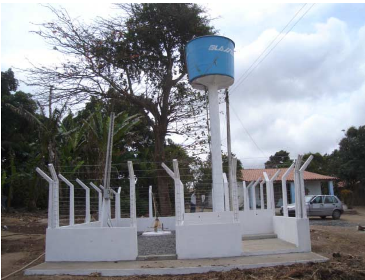
Foto 7.1 - Fase construtiva final do SSA Sítio Salgado II
