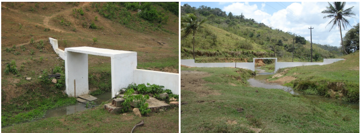
Figura 3.7 – Vista da seção de controle da Bacia do Alto Gameleira.
