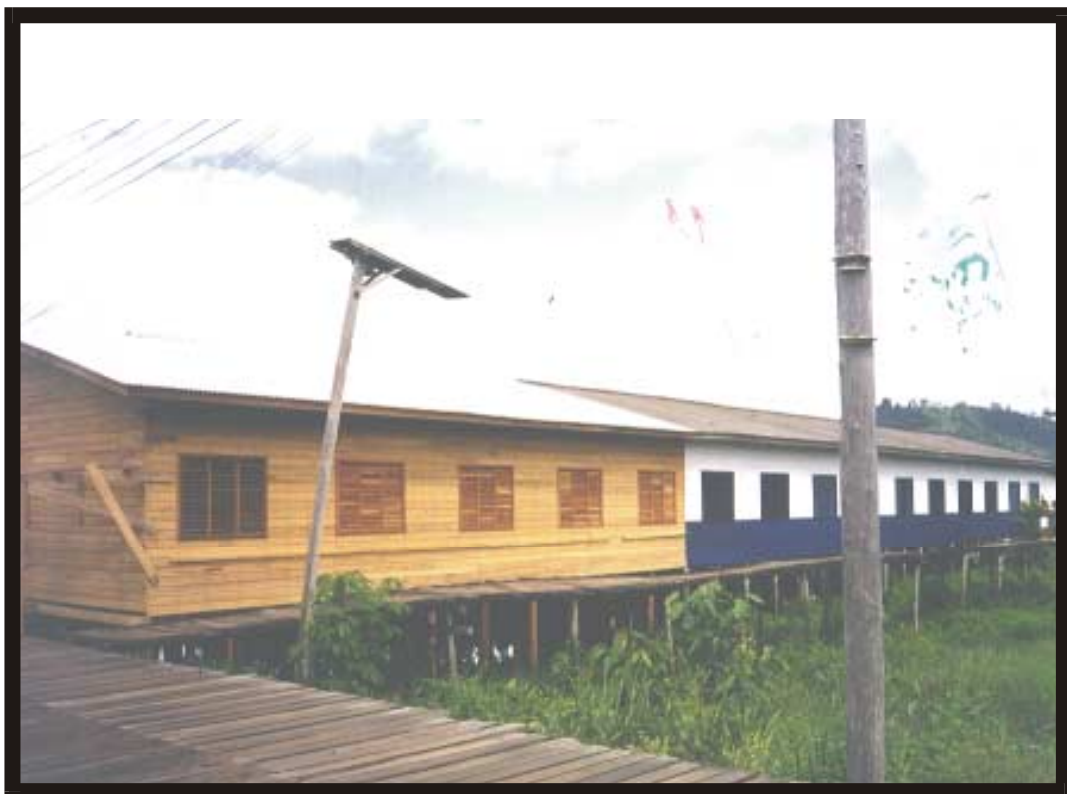
Foto11 - Características das Escolas do Município, existentes e em construção.
