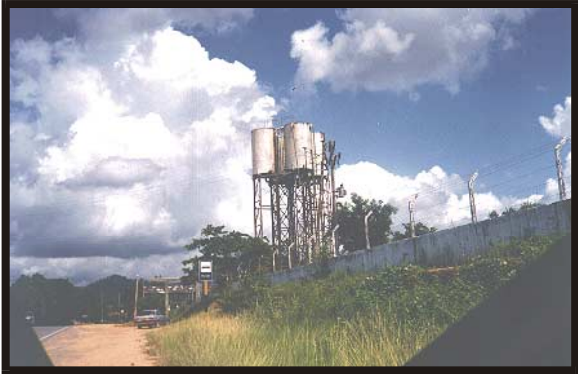
Foto 24 - Vista da estação de Tratamento de Água Desativada.
