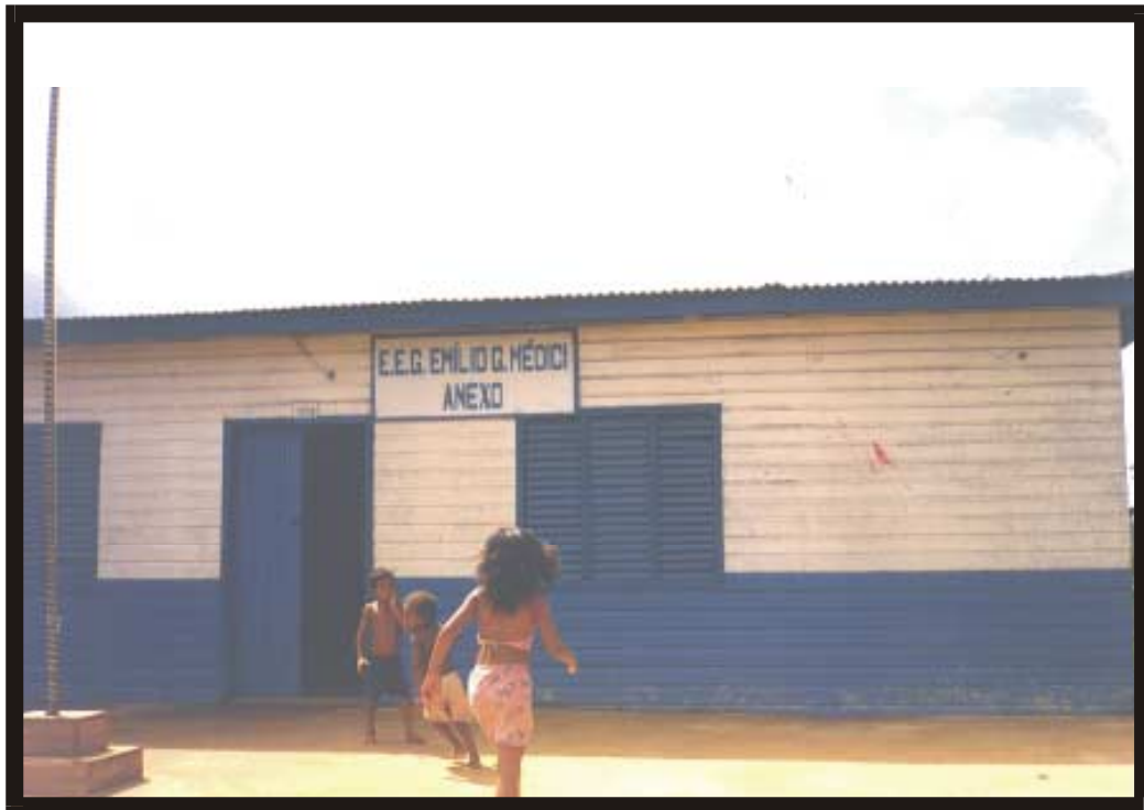
Foto11 - Características das Escolas do Município, existentes e em construção.
