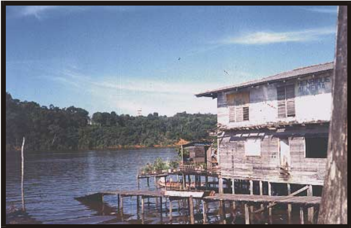
Foto 27 - Vista das construções residenciais existentes na zona alagada de Laranjal do Jari.
