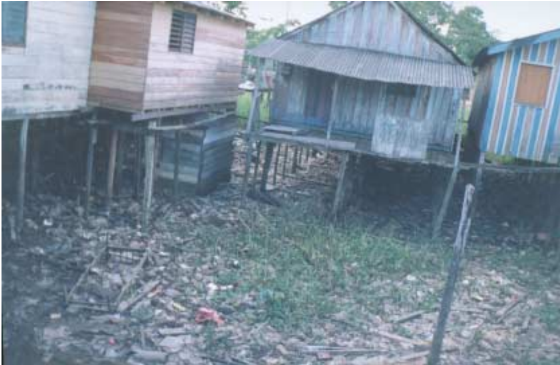
FOTO 03: Tipo comum de palafitas encontradas no setor inundado, onde é observado o lixeiro na zona alagada, que também serve como banheiro, e a água algumas vezes é utilizada para os afazeres domésticos.
