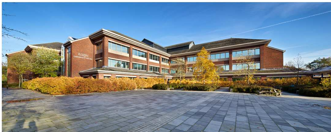
Figura 5: Prédio da Universidade de Warwick
