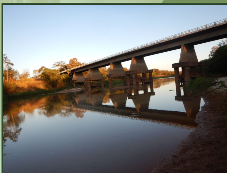
Rio da Prata em Ponte BR-040
