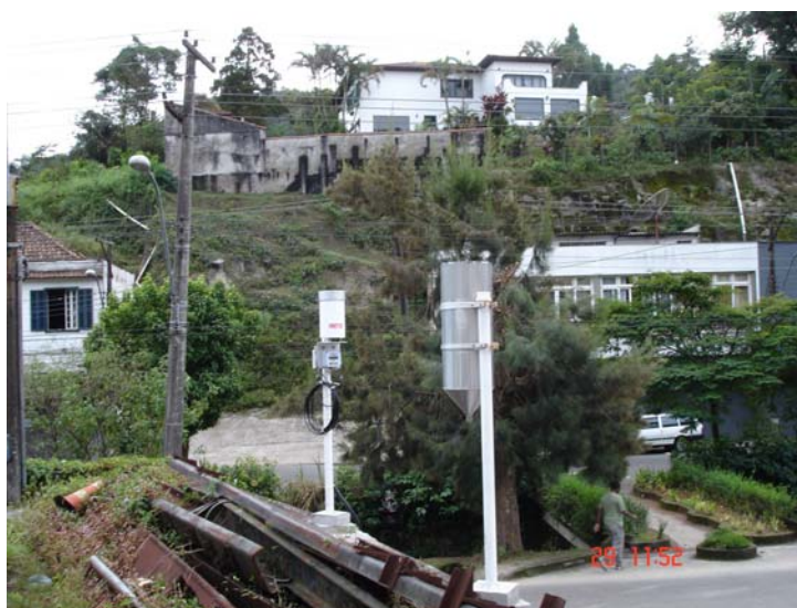
Figura 10 – Estação Esperança tipo PrFrDA – vista dos pluviômetros convencional e automático.
