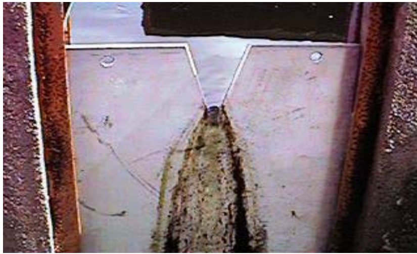
Figura 4.4: Vertedor triangular posicionados em cada lagoa
