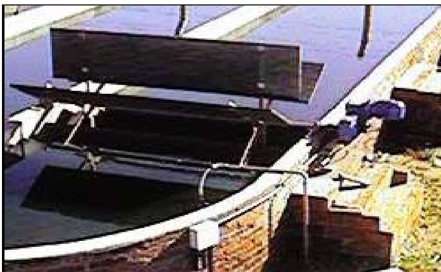
Figura 4.5: Conjunto de mistura/ propulsão rotor/moto-reductor
