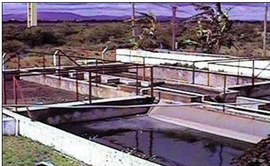
Figura 4.2: Reator anaeróbio de fluxo ascendente
