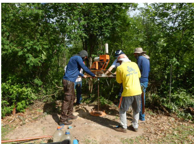
Figura 3.2 - Execução do FT-01. Foto: acervo dos autores.
