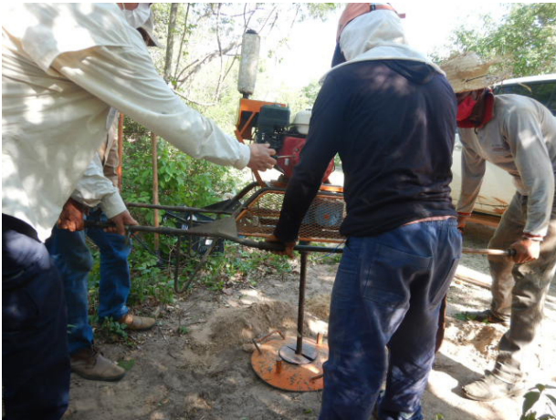
Figura 3.8 - Execução do FT-05. Foto: acervo dos autores.
