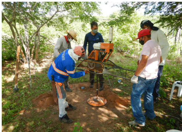
Figura 3.6 - Execução do FT-03. Foto: acervo dos autores
