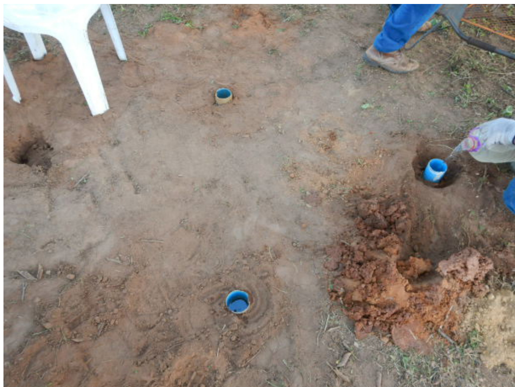
Figura 3.7 - Execução do teste de infiltração na Área 4. Foto: Acervo dos autores.
