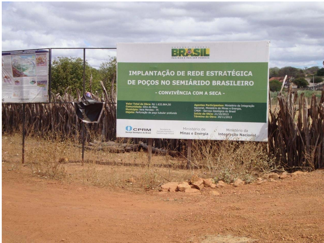
Fotografia 1: Placa de obra no local do poço (2013, durante a perfuração)
