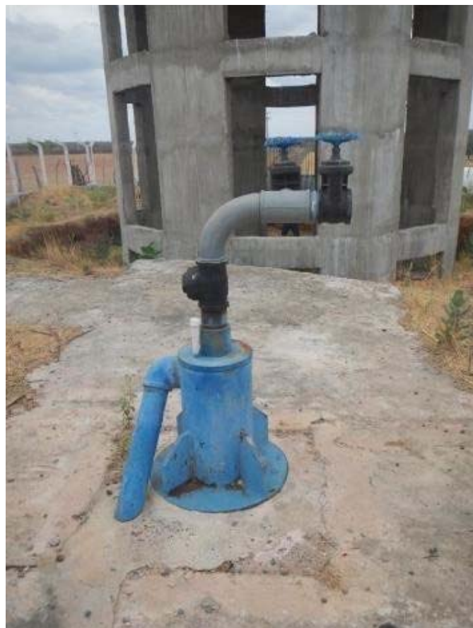
Fotografia 8: Saída do poço com reservatório ao fundo (2021)
