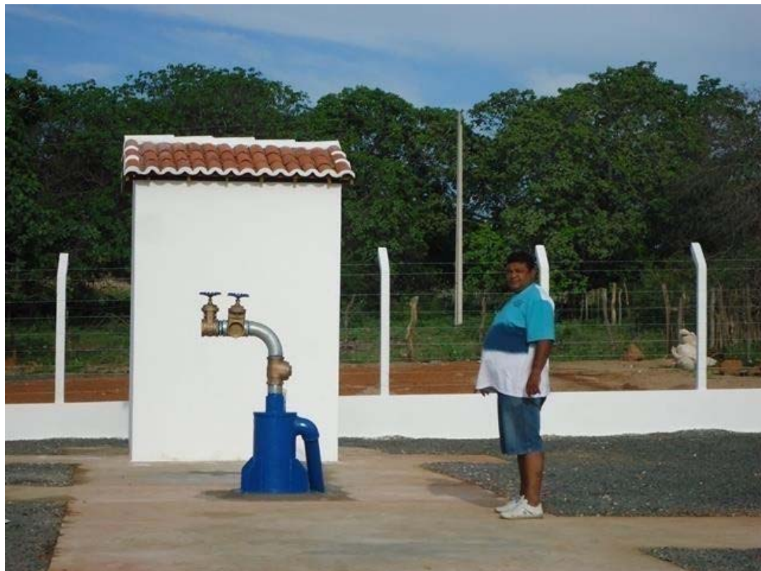
Fotografia 4: Cavalete do poço, com duas saídas de água; ao fundo, casa de proteção do quadro elétrico para acionamento e proteção da bomba submersa (2013)
