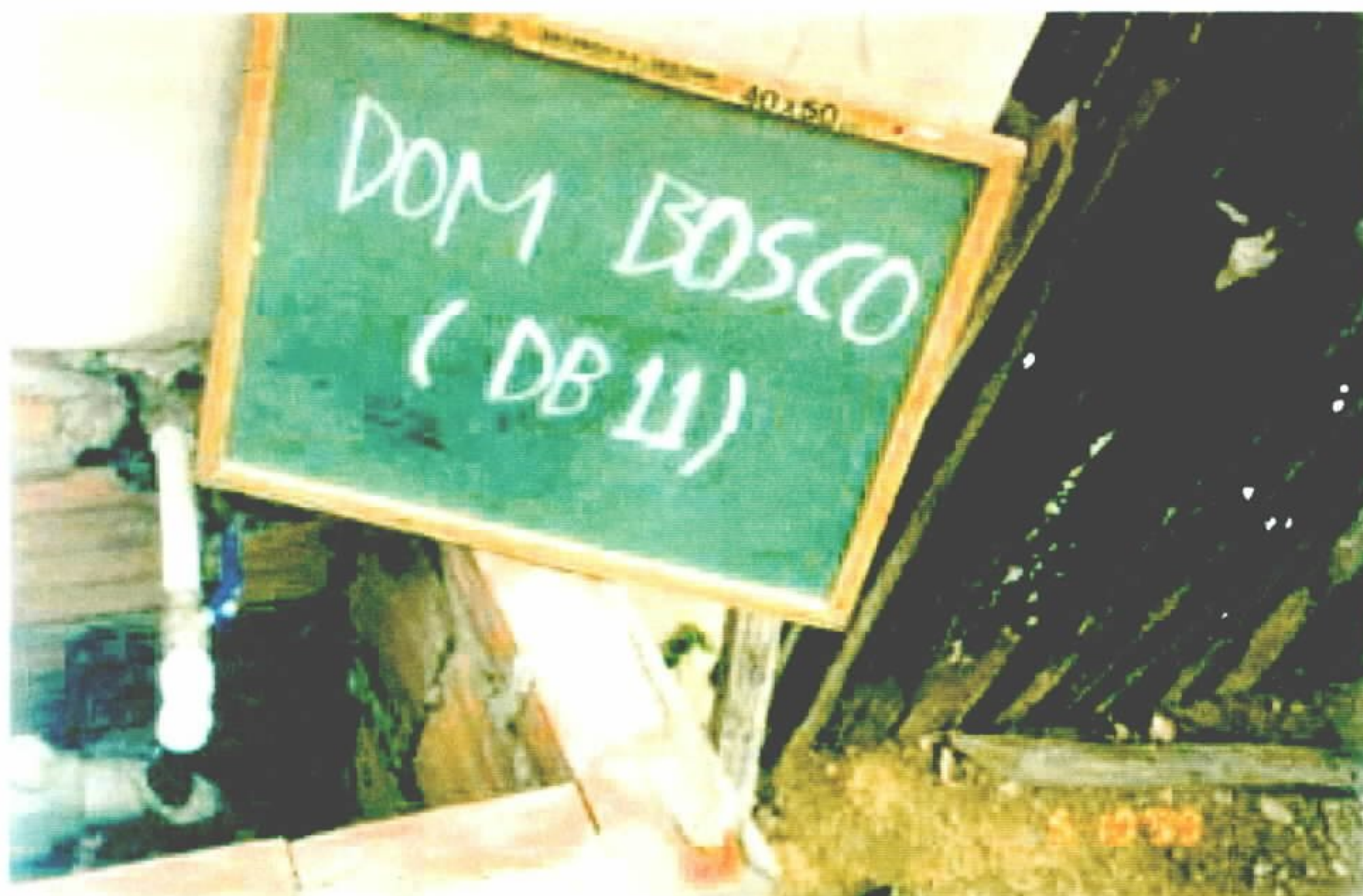
Foto 5 - Poço tubular produtivo cercado com muro de alvenaria, porém sem laje de proteção sanitária. Notar proximidade de pocilga. Local: Cooperativa Agrícola de Unai - Entreposto Dom Bosco. UTM: 365055E/8159216N.
