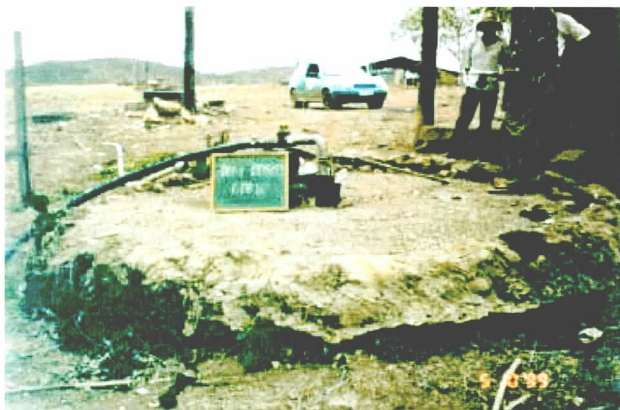
Foto 4 - Poço tubular com laje não apropriada e solapamento da mesma. Notar proximidade da residência e curral. Local: Fazenda Luar do Sertão. UTM: 354502E/8162916N.
