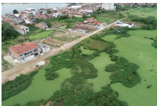
Figura 7 – Parte da Lagoa das Pedrinhas aterrada para construção de vias de acesso e residências.
