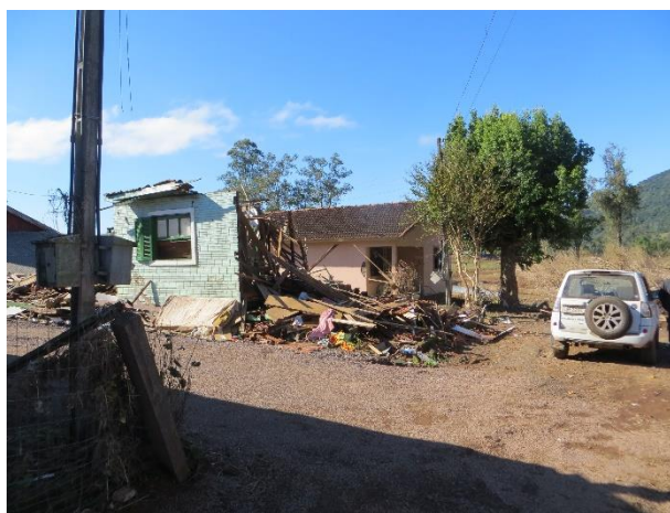
Figura 17 – Residências atingidas por inundação brusca.
