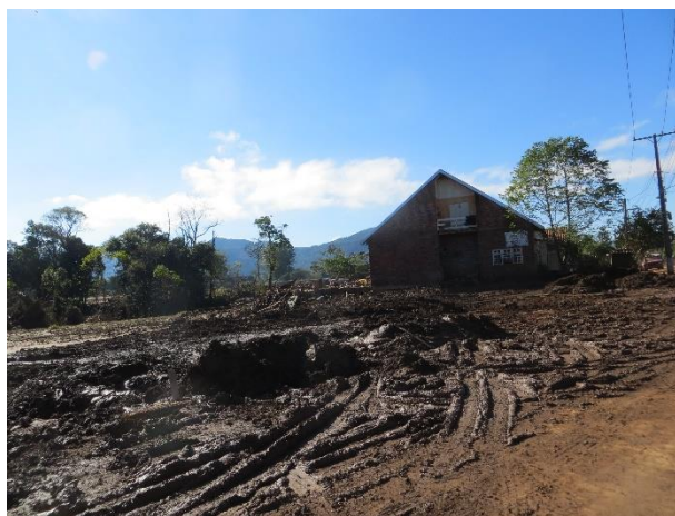
Figura 15 – Inundação com cotas elevadas, atingindo diversas casas. Local de deposição de lama e detritos.
