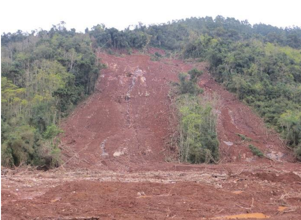
Figura 4 – Vista geral do deslizamento em encosta, ao lado do vale do Arroio Tamadué.
