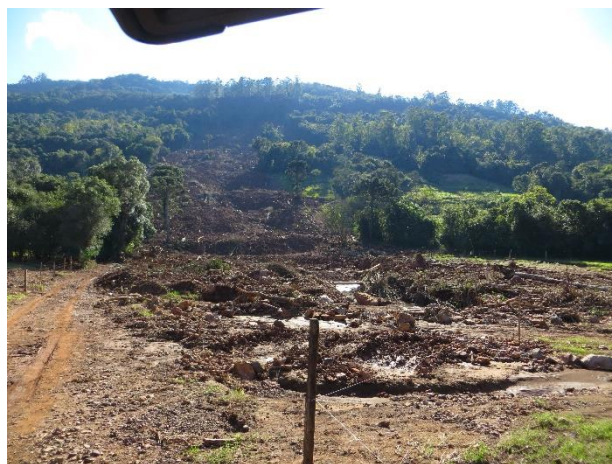
Figura 12 – Deslizamento planar com fluxo intenso de escoamento superficial de água, resultando na exposição do maciço rochoso (Fm. Serra Geral).
