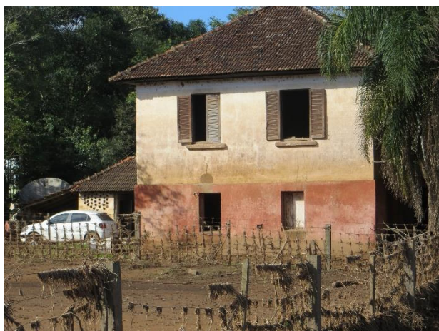
Figura 14 – Cota de inundação atingiu o segundo andar, muito próximo ao telhado.
