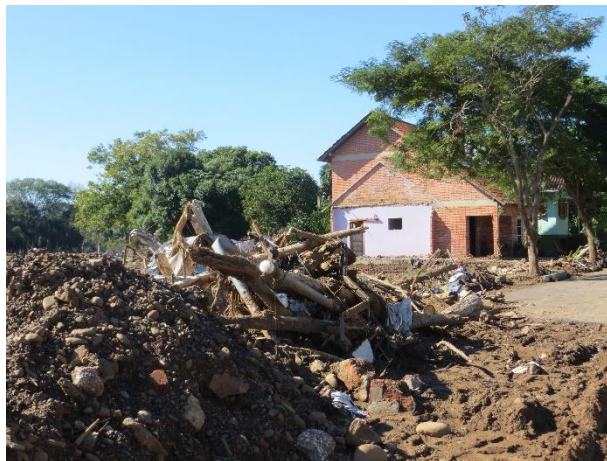
Figura 19 – Diversas casas danificadas.
