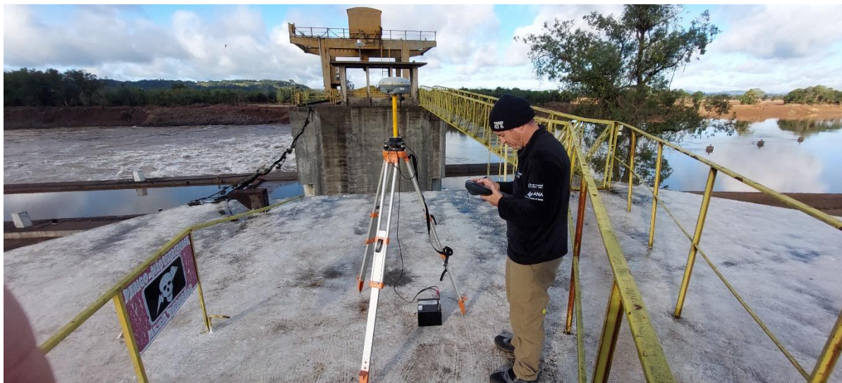
Figura 2. Levantamento com GPS-RTK na estrutura da eclusa de Bom Retiro do Sul.
