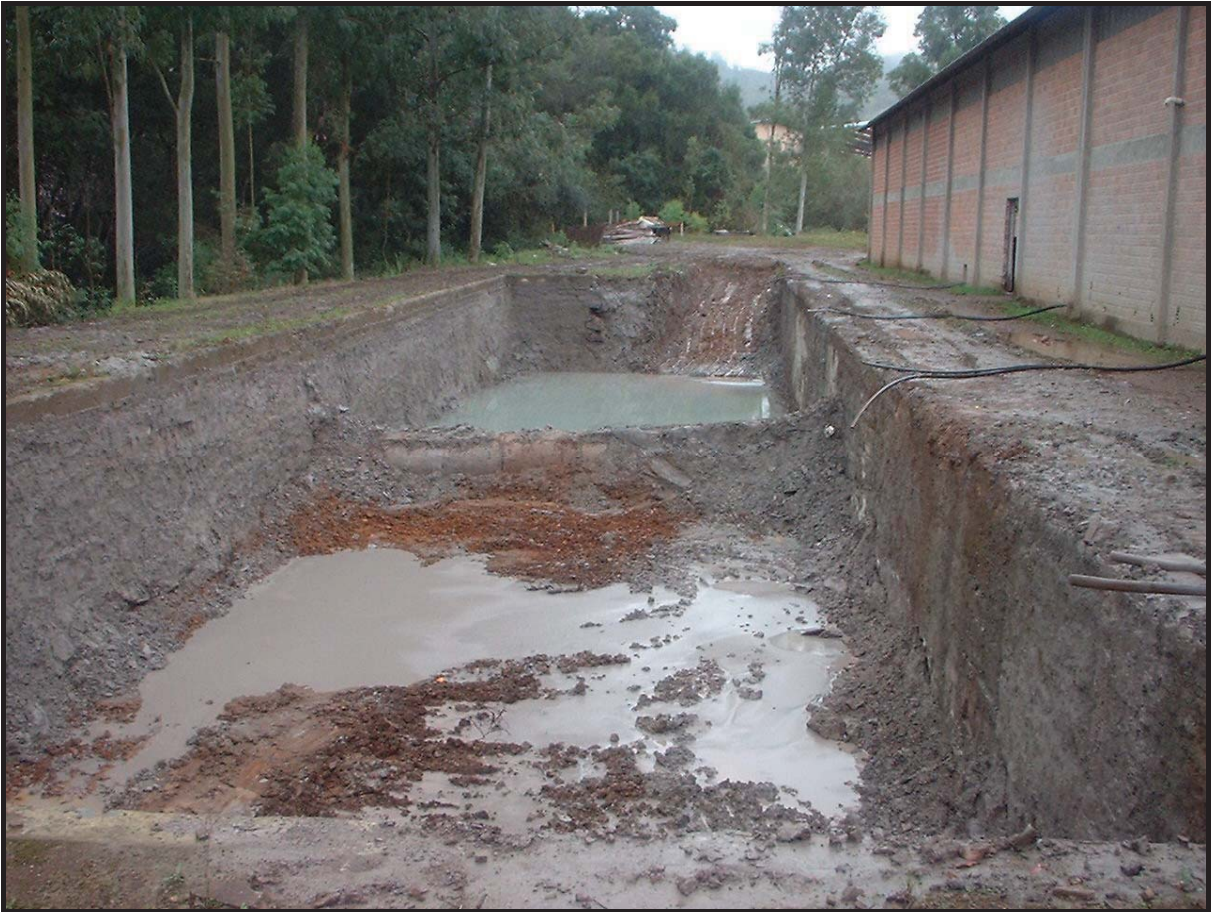
Figura 05 – Bacia de deposição do rejeito da empresa São Cristóvão
