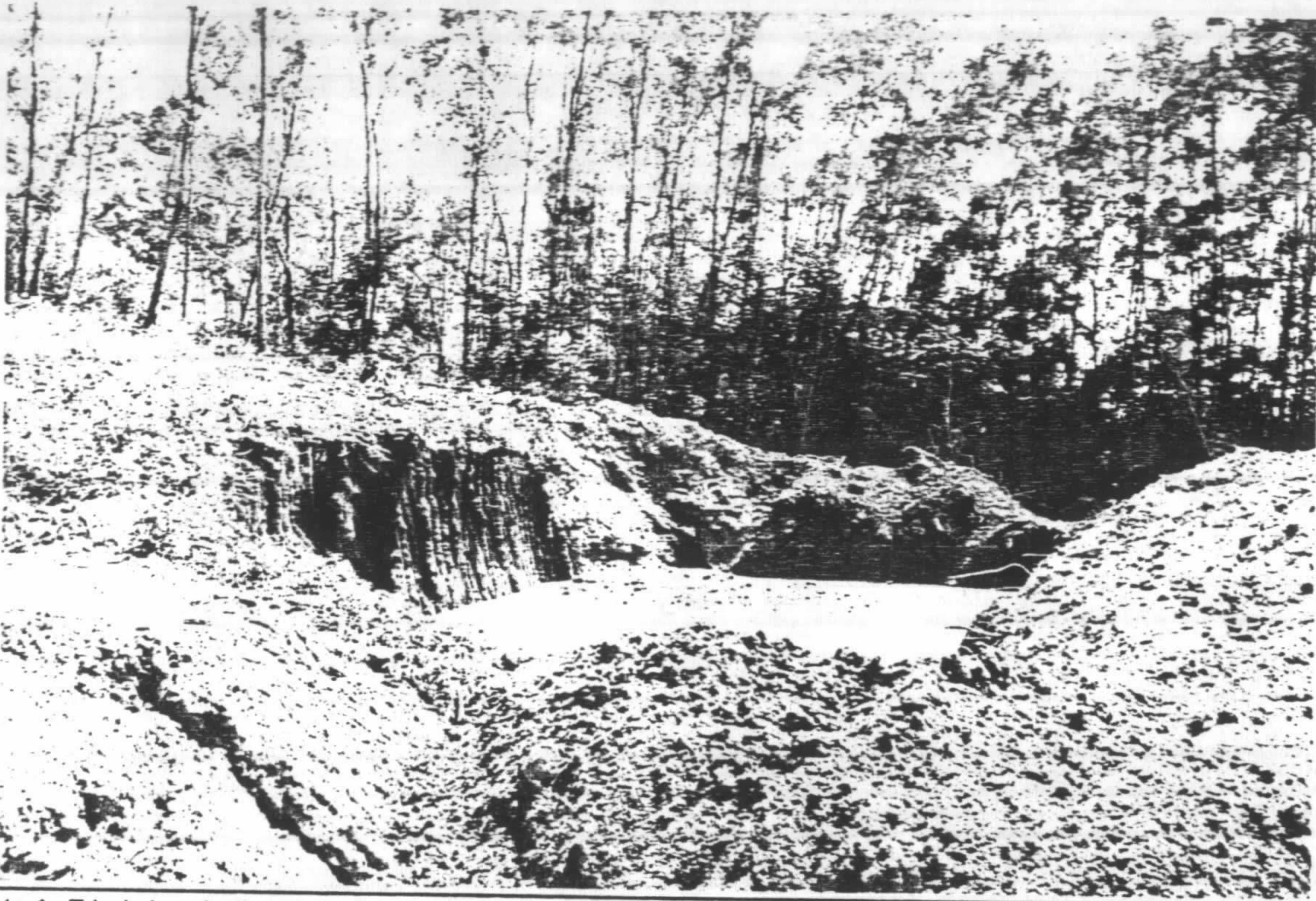
Foto 1 - Trincheiras de disposição de Lodo
