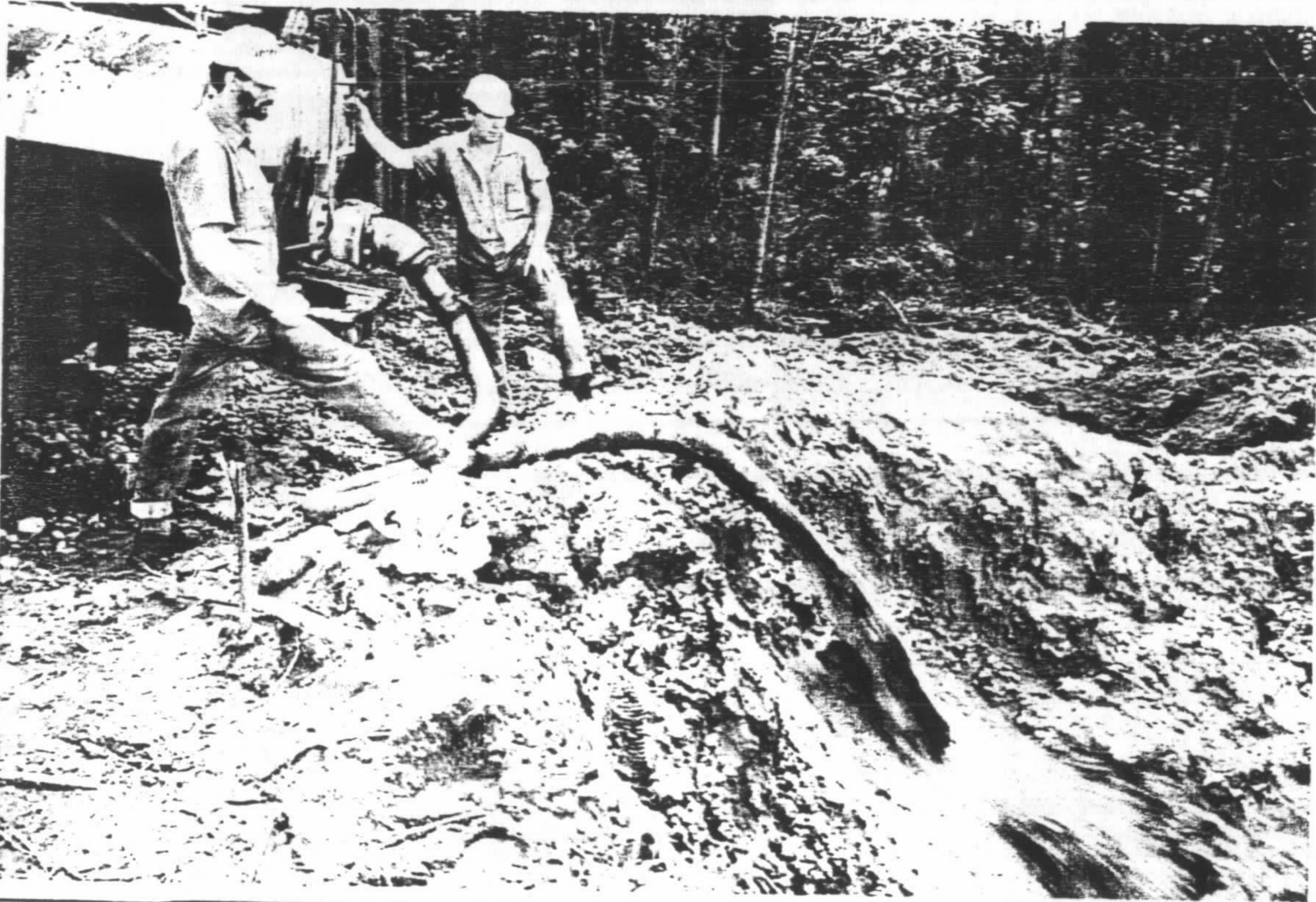
Foto 2 - Detalhe da disposição do lodo
